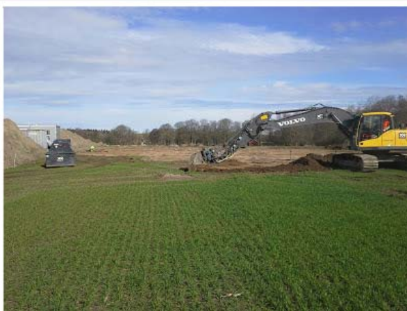
Bild fr schaktning på väg mot nr 100.
