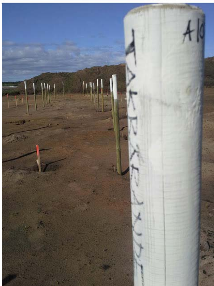
Delar av uppstolpningen till långhuset från Säware 99. Stolparna syns riktigt bra från vägen mellan Vinninga och Filsbäck. En drive-by upplevelse.
