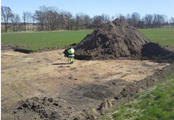
Vägs ände? Södra delen av Sävere 100. Kanske vi utvidgar i morgon el fredag för att inte lämna kvar något i vägarbetsområdet.
