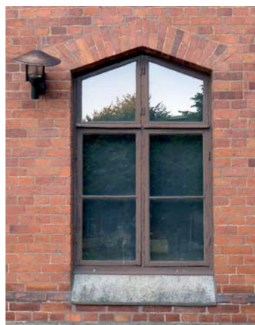
Träffönster i våningen under aulan. Typen förekommer också i klassrummen mot söder. T.h. ett blindfönster, troligen med bågar från 1800-talet.
