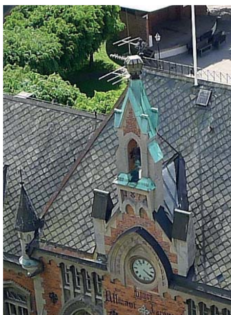
Klocktornet är täckt med kopparplåt, nockar och kupor med järnplåt. Foto 2012.
