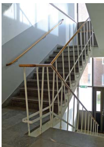
Trapphus vid södra entrén. 2014.
