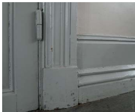
Dörrfoder och något enklare, lägre, golvlister i vestibulen, vindsvån.
