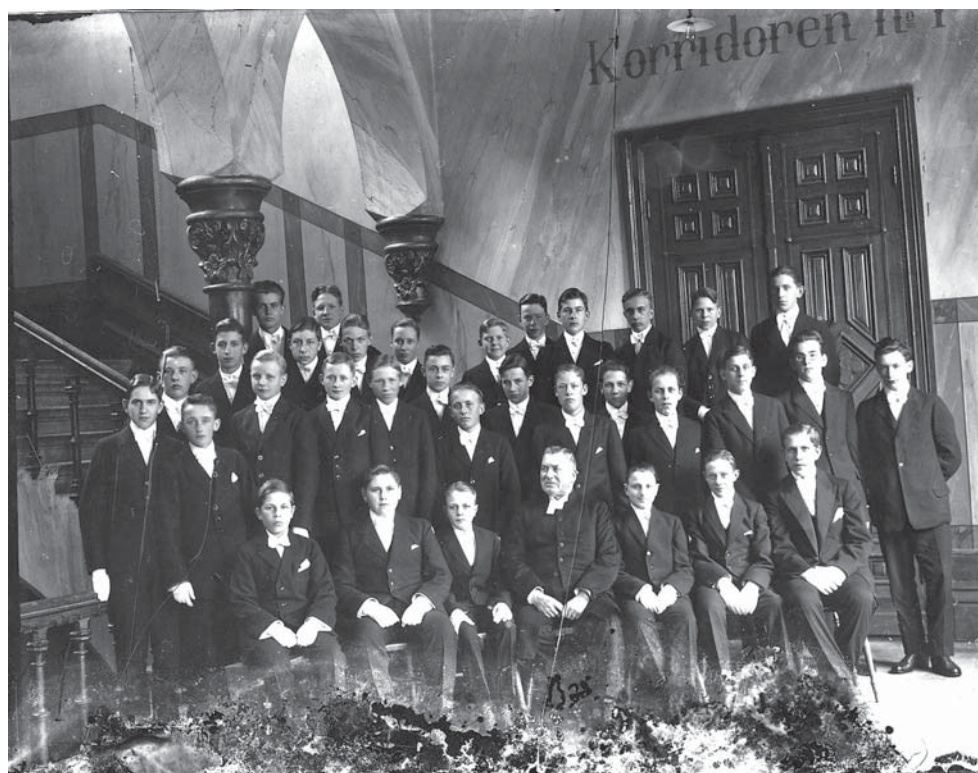
Trapphallen vid "Korridoren No 1", dvs vid dörren mot västra korridoren på 1 tr. Ett av mycket få äldre fotografier från trapphallen. Läggsärskilt märke till texten över dörren, marmoreringen på väggarna och fältindelningen upp till ca 200 cm. Foto 1924 i VGM bildarkiv.
