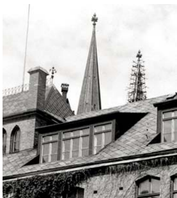
De stora takkuporna mot söder tillkom på 1930-talet. Detalj av foto ca 1950 i VGM bildarkiv.
