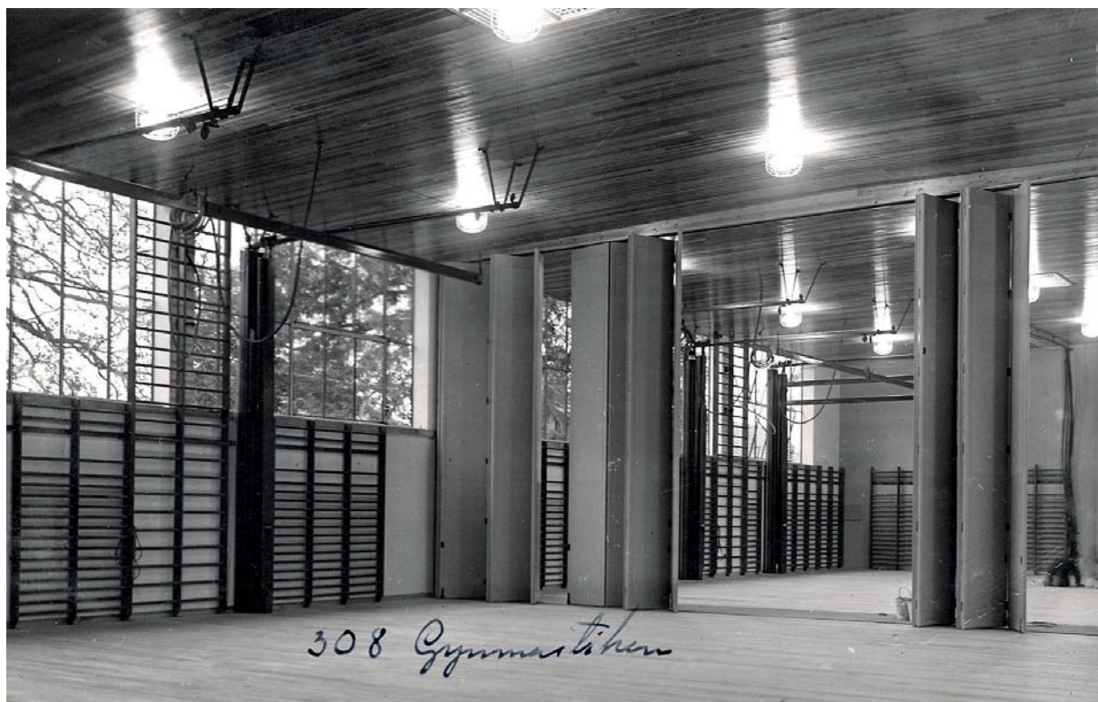
Gymnastiksalen sedd mot sydost när den var nybyggd. Notera vikväggarna i salens mitt. Foto Thesslund 1938 i VGM bildarkiv.
