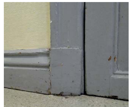
Golvlister och dörrfoder i korridor, vindsvån.
