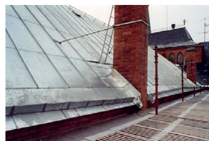
Byte av aulans plåttak hösten 2005.
