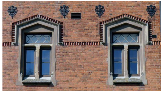
Fönster med korsposter av sten i bottenvåningen t. v. och vän. I tr t.h.. Notera även ankarlutarna av järn.
