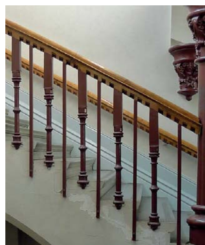
Förstärkning av gjutjärnsräcket med smala kompletterande järnstag 1996. Räcket hade dessförinnan vid något tillfälle höjts.
