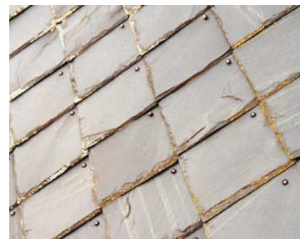
Skifferplattorna är idag skruvade mot underlaget.
