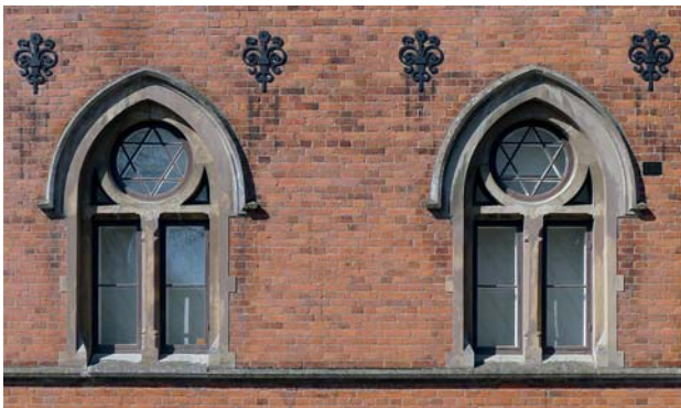
Fönster med korsposter av sten i bottenvåningen t. v. och vän. I tr t.h.. Notera även ankarlutarna av järn.
