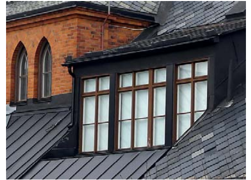
Takkupa mot söder. T.v. skymtar två i raden av nio spetsbågiga fönster på trapphusets sydsida.
