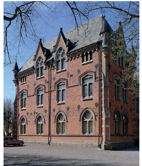
Alla fasader har ägnats samma omsorg om detaljer. Gavel mot öster.
