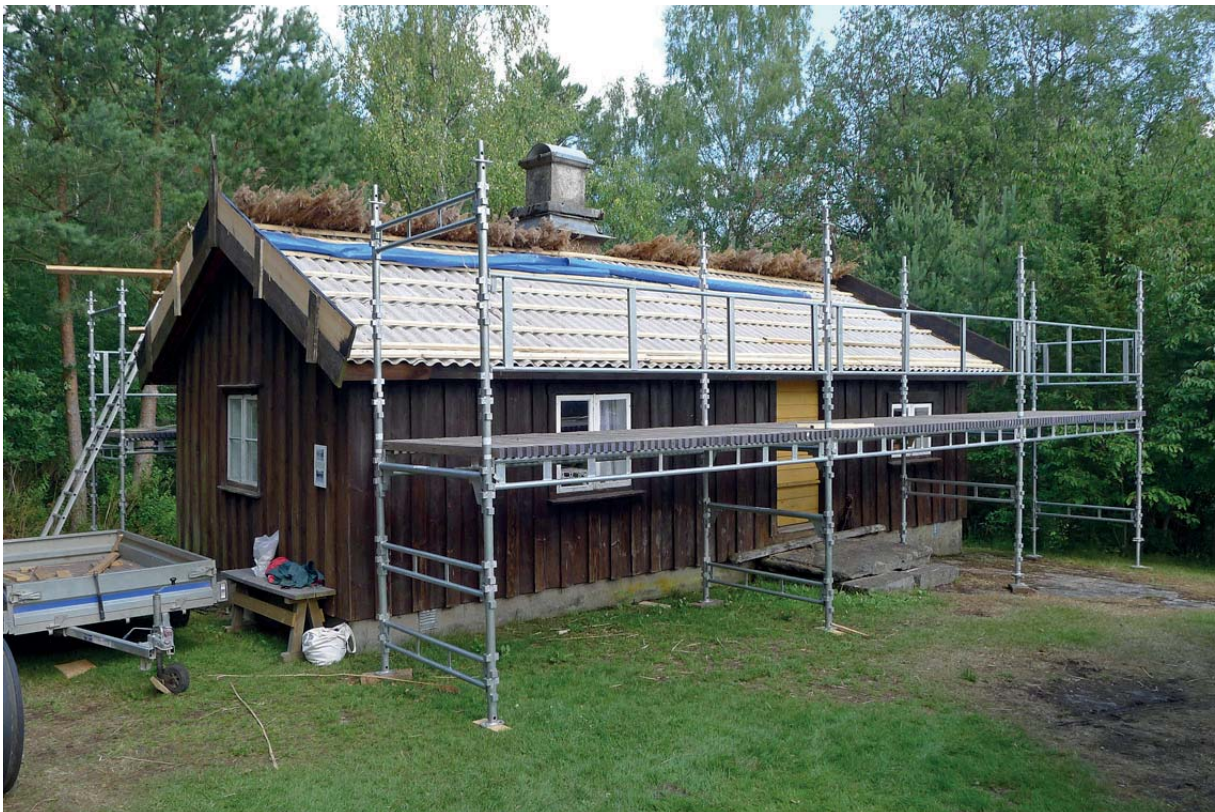
Takfallet mot gårdsplanen - bindreglarna monterade inför läggning av vassen på andra takfallet. Juli 2014.
