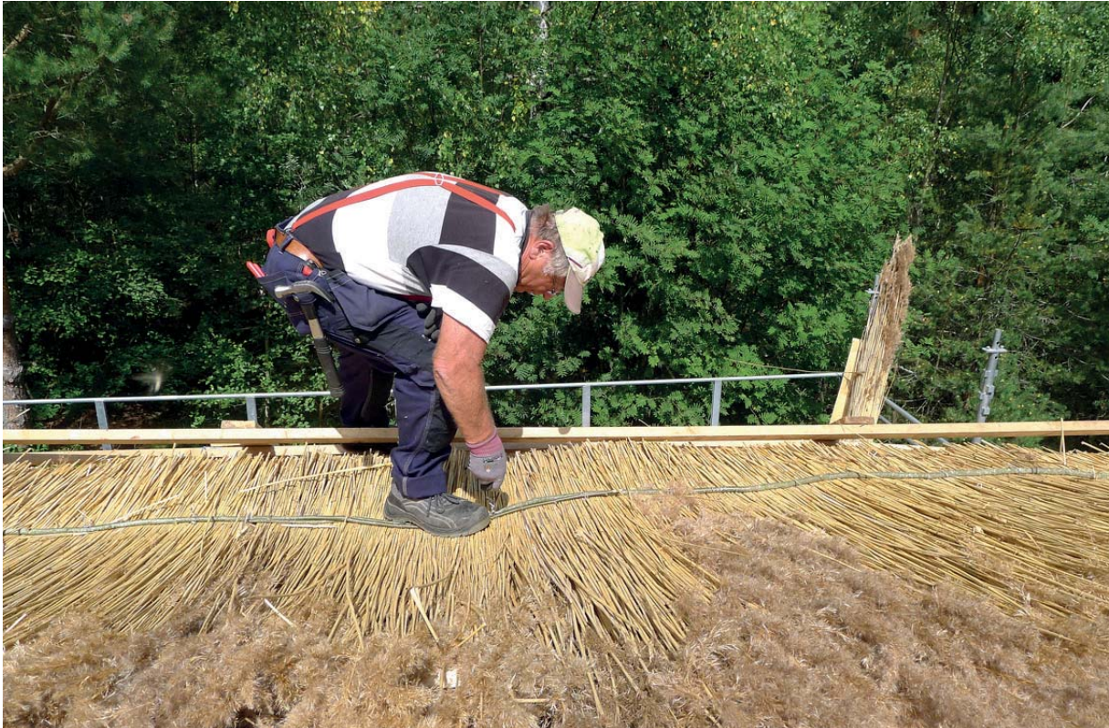
Bengt Rune drar åt ståltråden så att vassen ligger säkert. Juli 2014.
