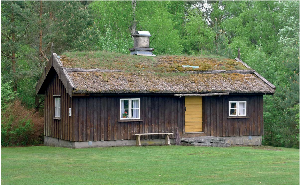
Emma Svans stuga före renoveringen av taket. Foto maj 2013.
