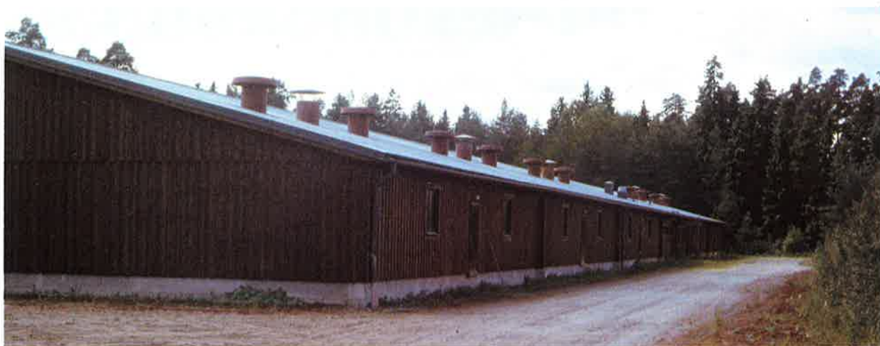
Svinförsöksstationen i Hallsberg togs i bruk i maj 1979. Investeringen för Scan Väst och Farmek ligger i storleksordningen 5 miljoner kr. Total byggnadsyta 2 540 m 2 ; stationen är indelad i tio avdelningar med separat foderförsörjning och luftväxling för att bibehålla ett gott hälsoläge. Plats för 560 djur.
