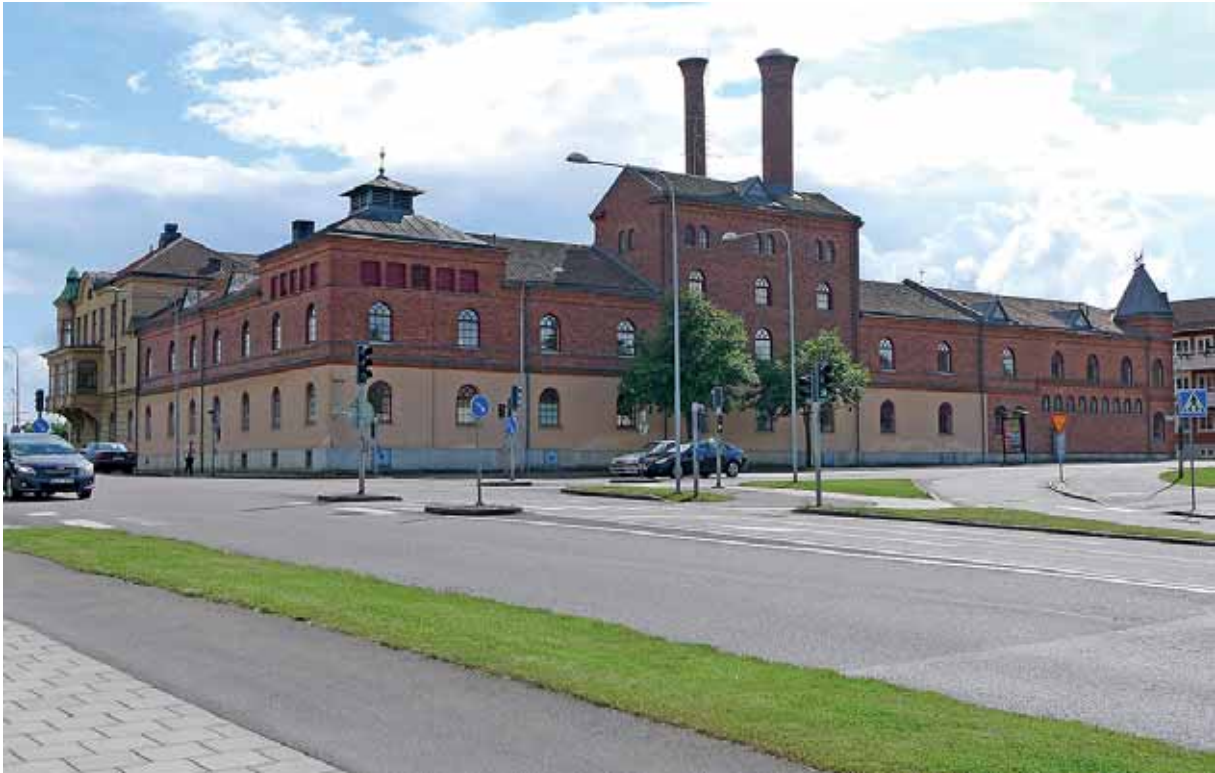
Kvarteret Saga med Bryggeriet Nordstjernen sett från NO. De höga skorstenarna har bedömts som viktiga landmärken i stadsbilden. Foto juni 2012.
