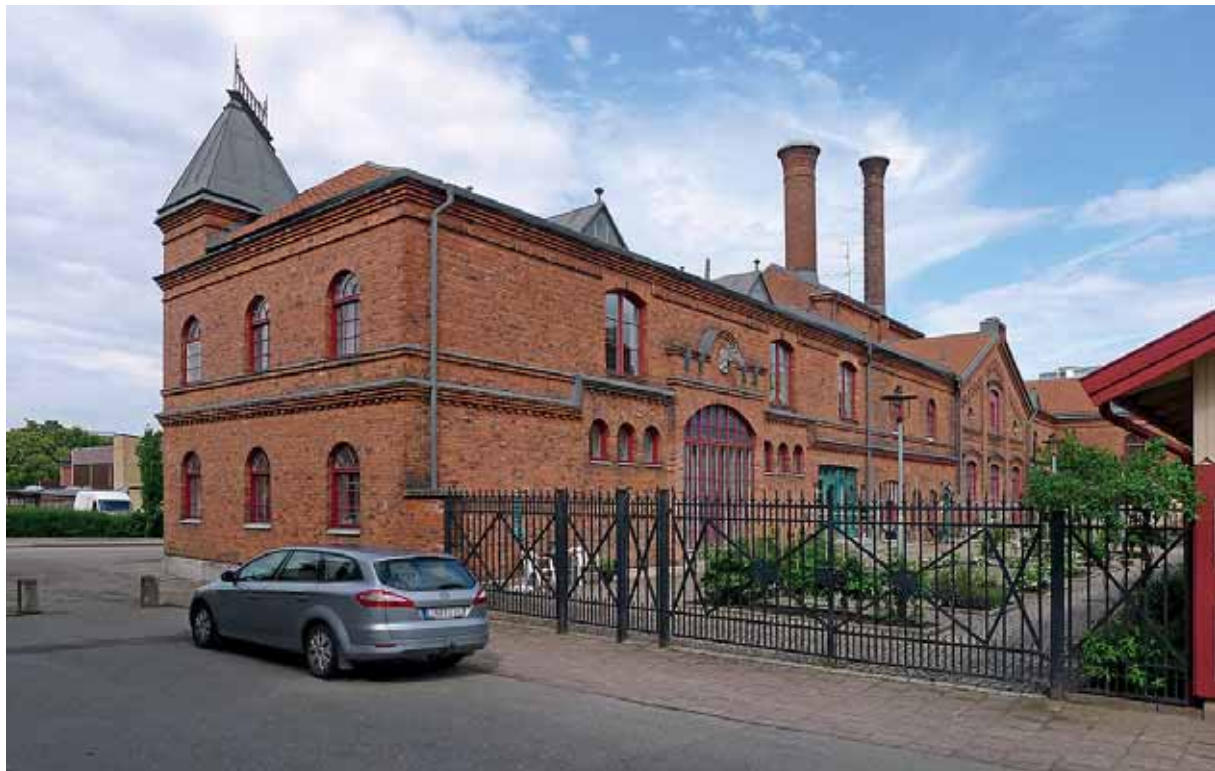
Närmast den fd stallbyggnaden och bryggerigården. Juni 2012.
