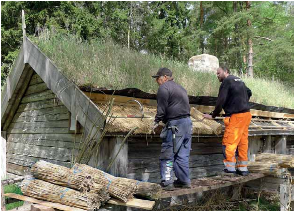
Bengt Rune och Jörgen, t.h., lägger ut vasskärvarna och skjuter upp dem under torven, som tillfälligt hålls undan av en bräda. Maj 2014.
