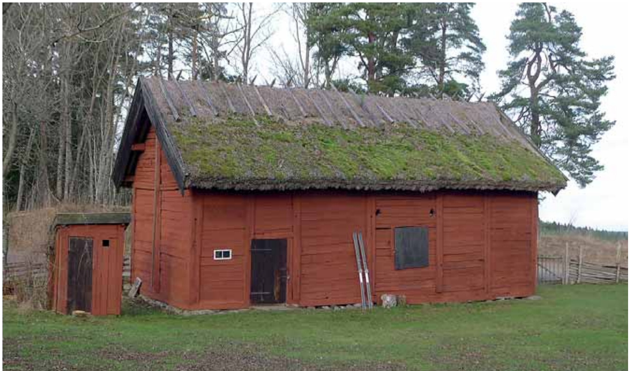
Skiftesverksladugården på Gluggetorpet före takarbetena. Fasaden in mot gårdsplanen. Foto nov. 2012.
