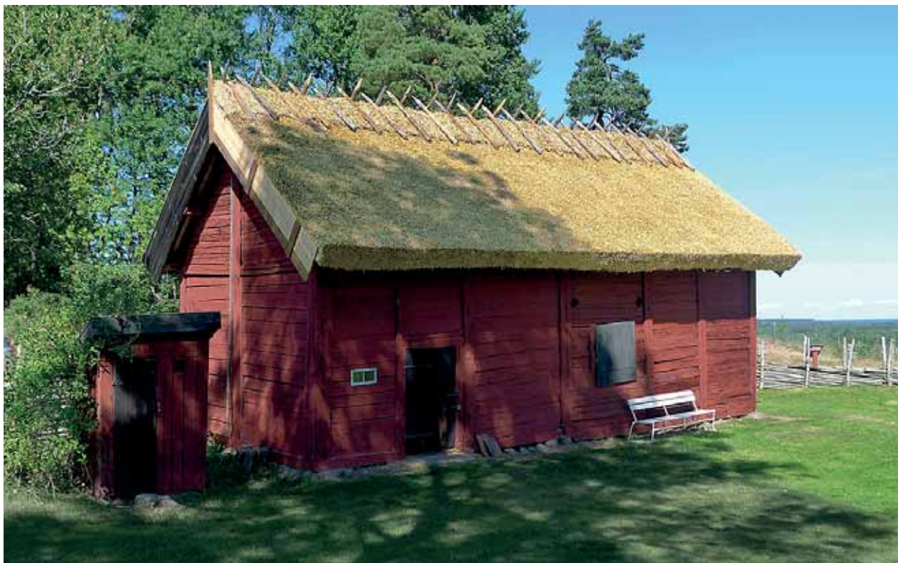
Södra takfallet klart på Gluggetorpets ladugård. 23 aug. 2013.
