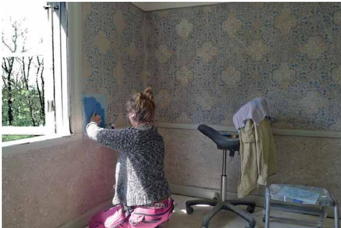
Maria arbetar med stöppling av schablonen för det blå mönstret på ytterväggen. Därefter sätts det vita mönstret. Maj 2013.
