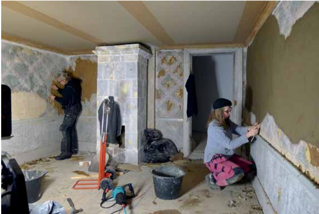
SO kammaren. Irene Haglind sysselsatt med att ta bort tapetrester, Maria Palm finjusterar den nya lerklining. Febr. 2013.
