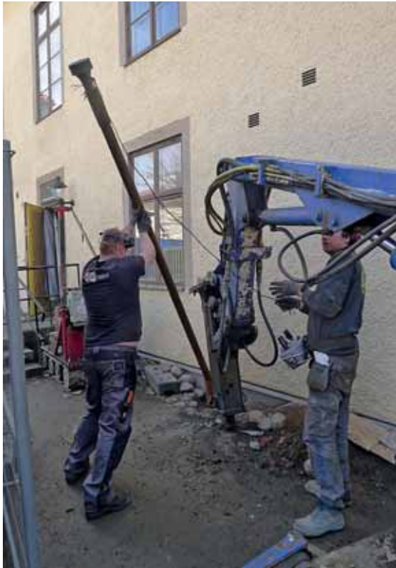
Pålning på gårdssidan. Dessa pålar var avsevärt längre än de som användes invändigt. Apr. 2014.
