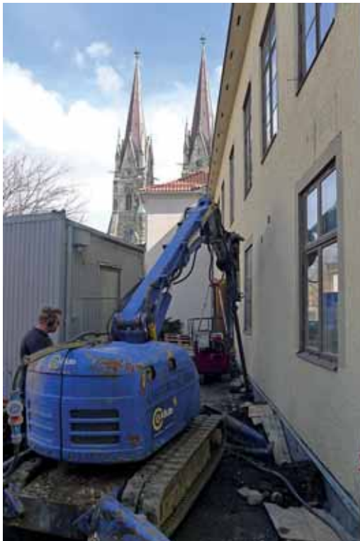
Vänster: Två á tre pålar krävdes för att nå fast grund. Höger: Igenläggning av marken på gårdssidan efter arbetenas avslutande. April resp. maj 2014.
