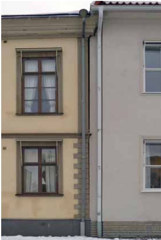
Rådhuset, fasad mot torget. Fläckarna på fasaden härrör från temporära lagningar efter sättnings-sprickor i putsen. Foto febr. 2013.
