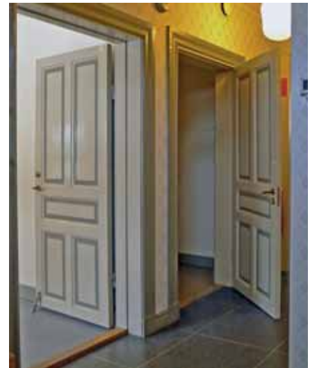
Ovan vänster: Upptagning av tidigare igensatt dörröppning mellan rum 103 & 104 på bottenvån. Juni 2013.
