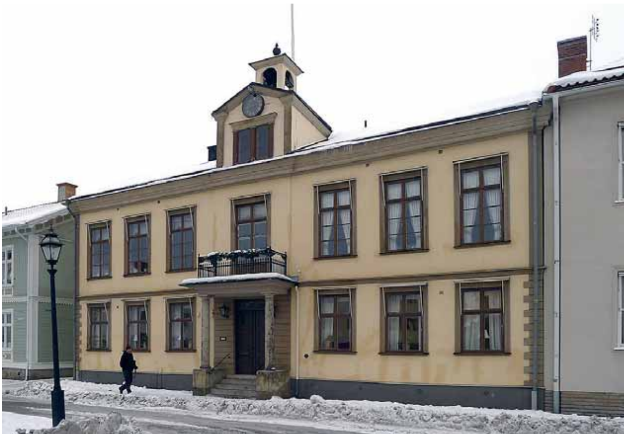
Rådhuset, fasad mot torget. Fläckarna på fasaden härrör från temporära lagningar efter sättnings-sprickor i putsen. Foto febr. 2013.
