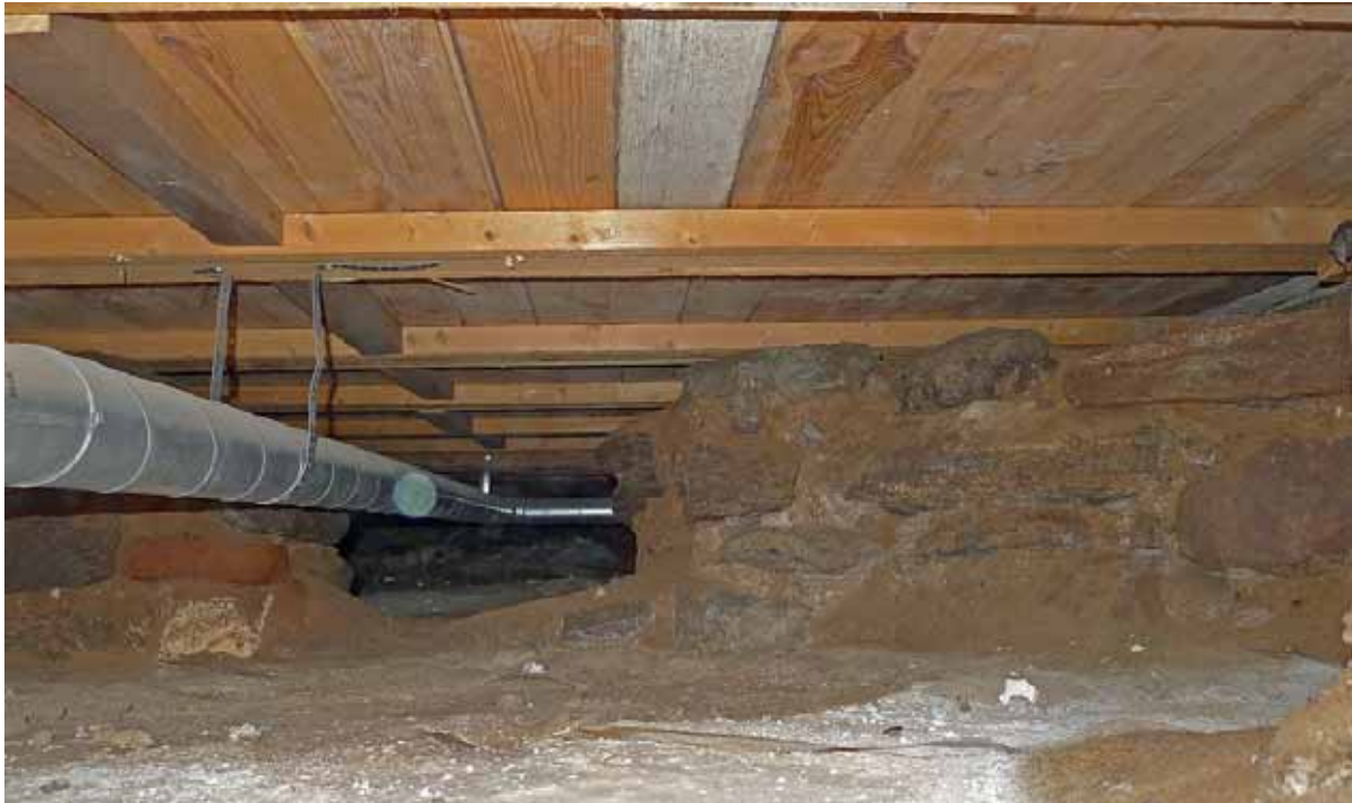
Bjälklaget till rum 102, sett mot väster, i samband med dragning av el. Lägg märke till det jämförelsevis nya virket i golvkonstruktionen. Stenmuren torde tidigare ha stött en mellanvägg. Maj 2014.
