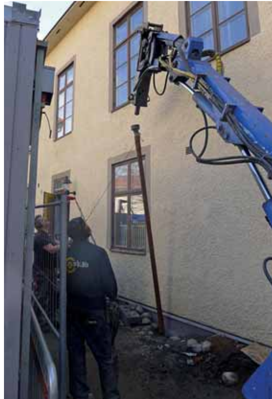
Pålning på gårdssidan. Dessa pålar var avsevärt längre än de som användes invändigt. Apr. 2014.
