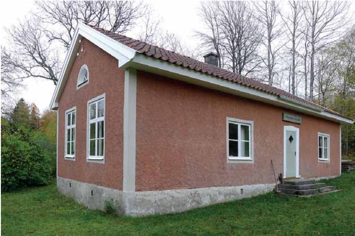
Fasadyornas puts har inte behövt röras vid denna renovering. Renovering av sockeln återstår. Okt. 2014.
