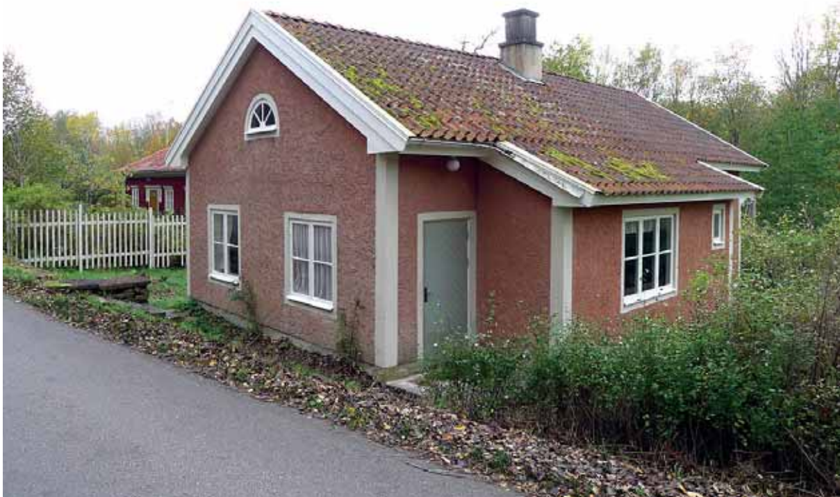
Fasad mot vägen och mot nordost. Putsskadan i dörrens omfattning lagad. Okt. 2014.
