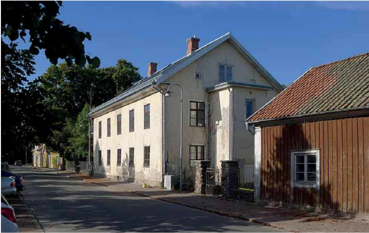
Baggstedtska gården vid Regeringsgatan, kv. Anden 6, under renovering i sept. 2013. T.h. del av kuskbostaden.
