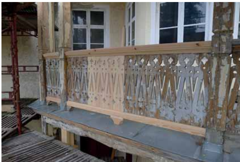
Nya över- och underliggare med stöd, samt några nya spjälor i övre våningens räcke. Här består golvet (än så länge - en trall ska tillverkas) av falsad plåt. Okt. 2012.
