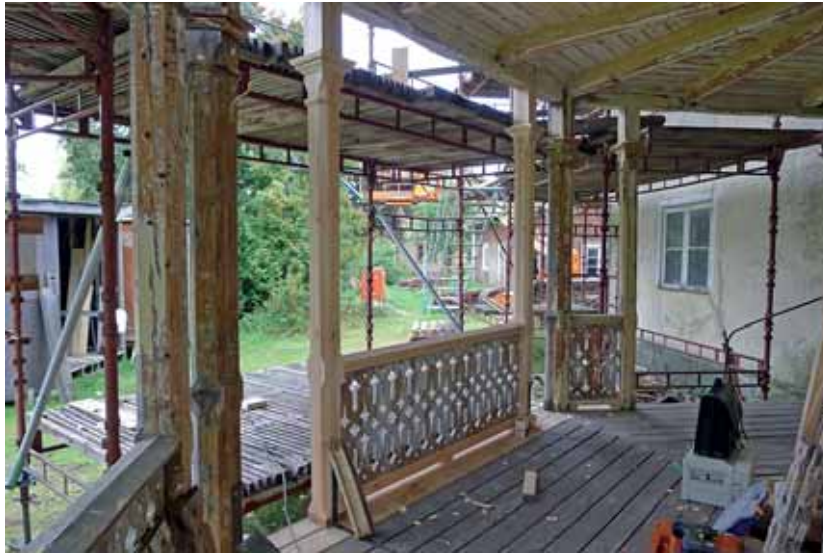
Bottenvåningens veranda under renovering. Sept. 2012.
