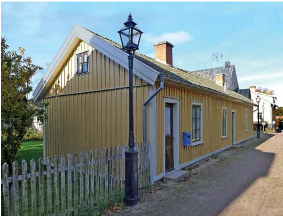
Dito, fasader mot öster (ga- veln) och gatan. 11 okt 2013.
