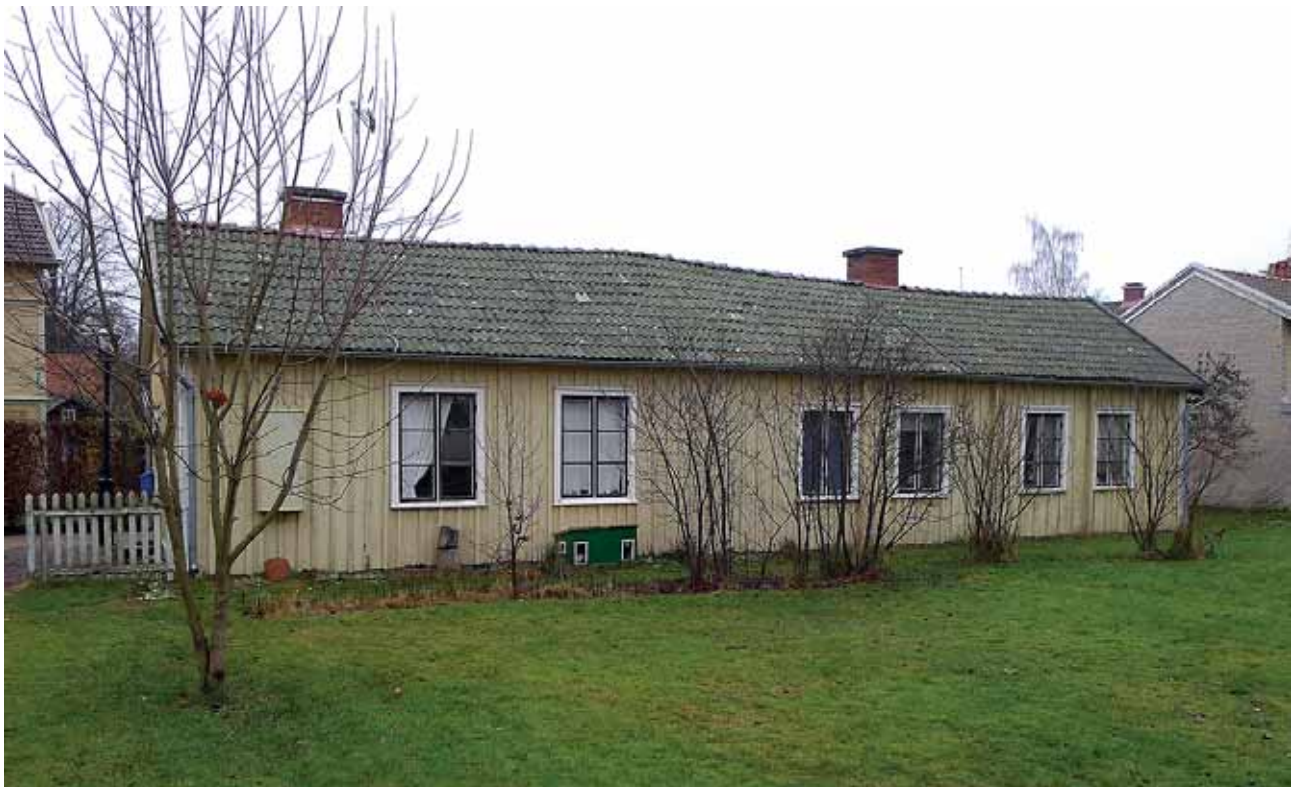
Västergränd 3, fasad mot gården före renovering och målning. Jan. 2013.
