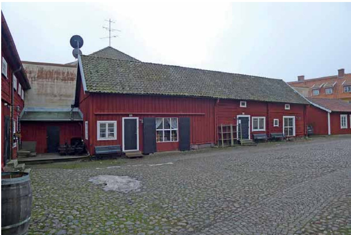
Den hitre delen (till stupröret i mitten) med locklistpanelen är ett tillbygge av stolpverk medan den bortre är ett knuttimrat äldre hus. Jan. 2013.
