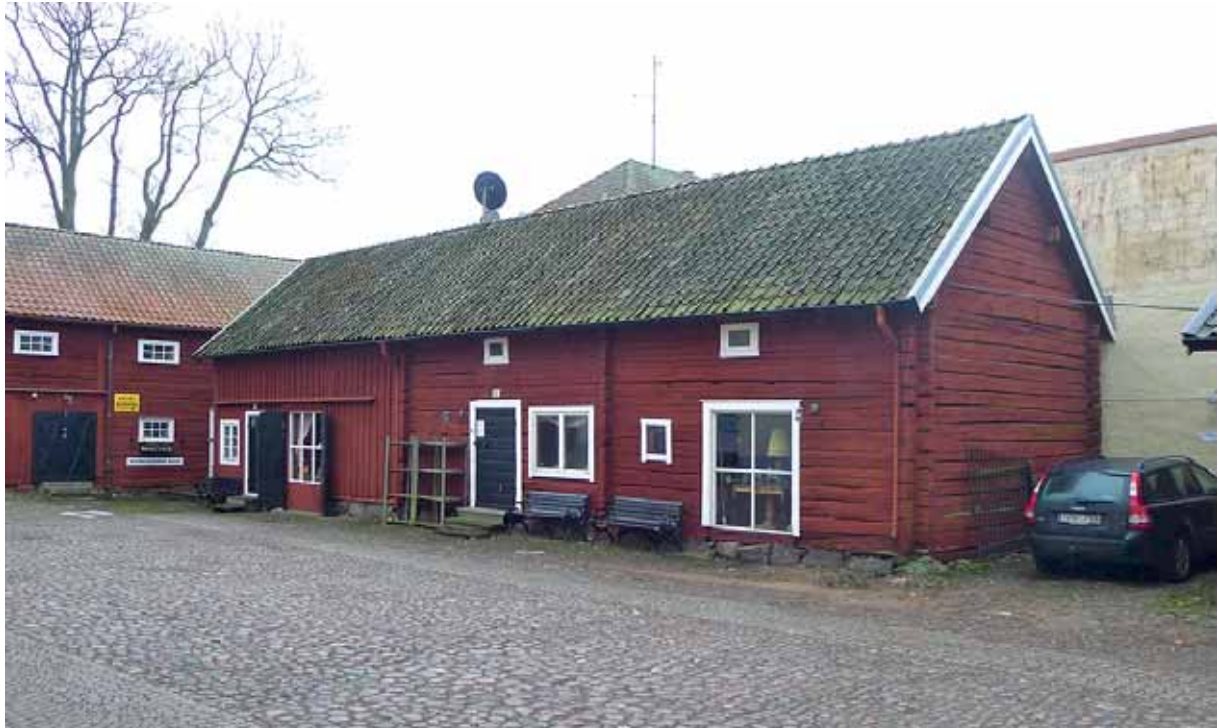
Gårdshuset vid södra tomtragrnsen. Fönster har satts in i det som troligen tidigare varit dörröppningar. Jan. 2013.
