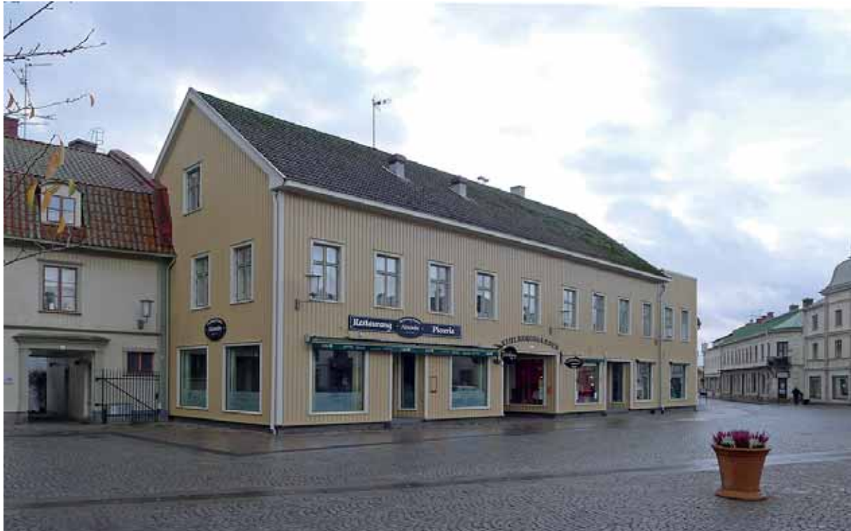
Kihlbergsgårdens gathus vänder en lång fasad mot Stora Torget. Jfr äldre bild sid. 1. Foto jan. 2013.
