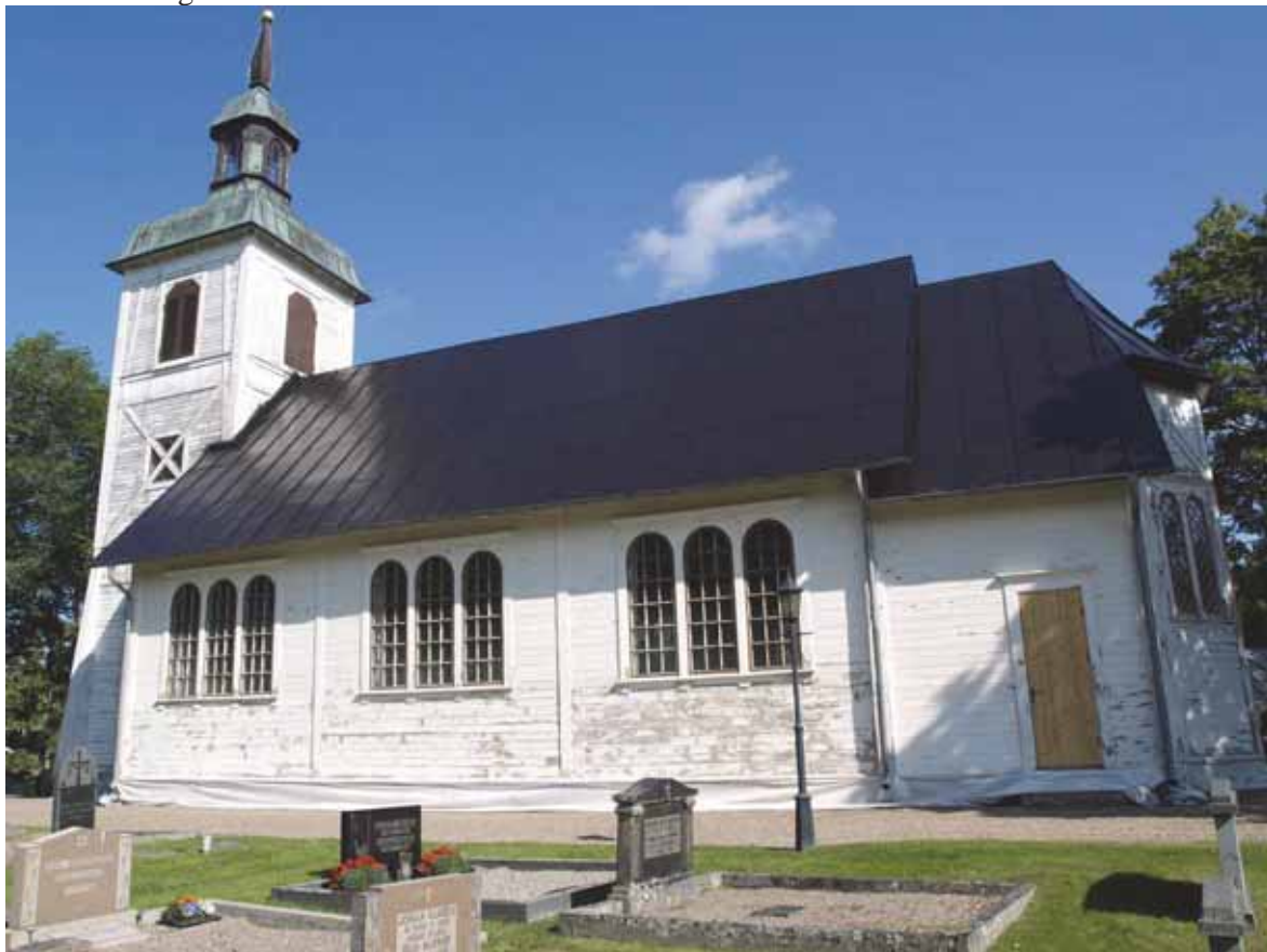
Bild 8 Taket färdigmålat, S takfallet.
