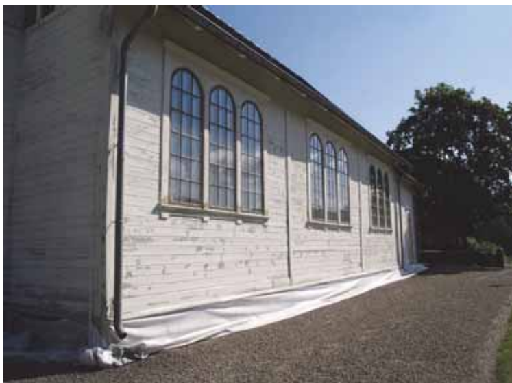
Bild 9: S fasaden tvättad och slipad.
