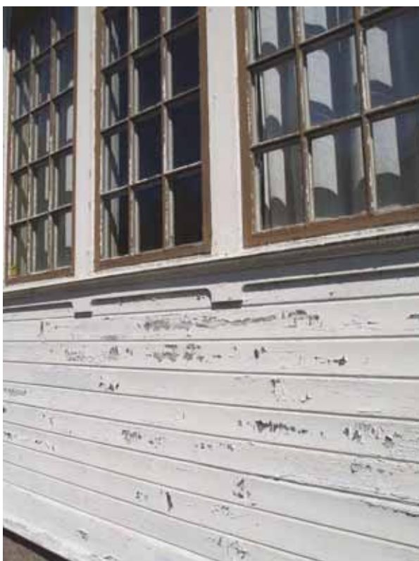
Bild 4: Närbild södra fasaden före.
