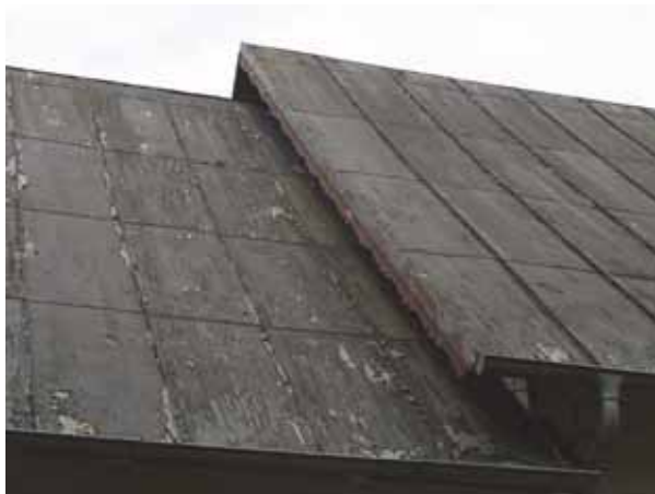
Bild 2: Närbild på plåttaket före
