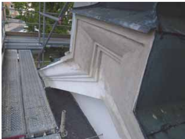
Del av frontonen på västportalen under arbetet. VGM_jenbj8_Tidaholms_kyrka_puts_o_plat_2013-05-28_1.jpeg
