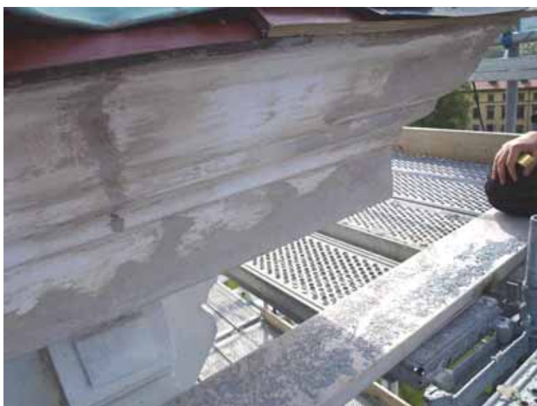
Hörnlagningarna under arbetet. VGM_jenbj8_Tidaholms_kyrka_puts_o_plat_2013-05-28_2.jpeg
