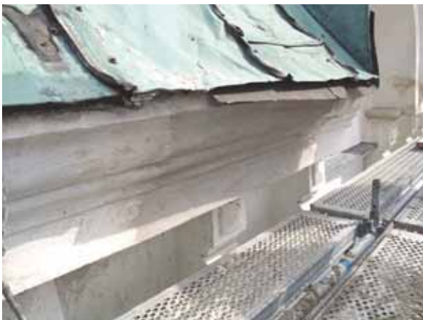
Putslagningarna innan avfärgning på takfoten. VGM_jenbj8_Tidaholms_kyrka_puts_o_plat_2013-05-28_2.jpeg
