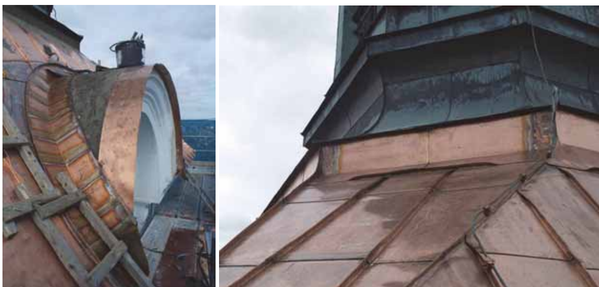
Under plåttäckningen av takkuporna. VGM_jenbj8_Tidaholms_kyrka_puts_o_plat_2013-08-29_3.jpeg
