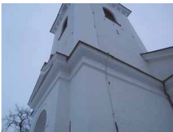
Gesimslisten efter åtgärderna. VGM_jenbj8_Tidaholms_kyrka_puts_o_plat_2013-12-10_3.jpeg
