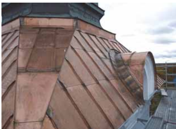
Den nylagda torntaksplåten. VGM_jenbj8_Tidaholms_kyrka_puts_o_plat_2013-10-09_3.jpeg
