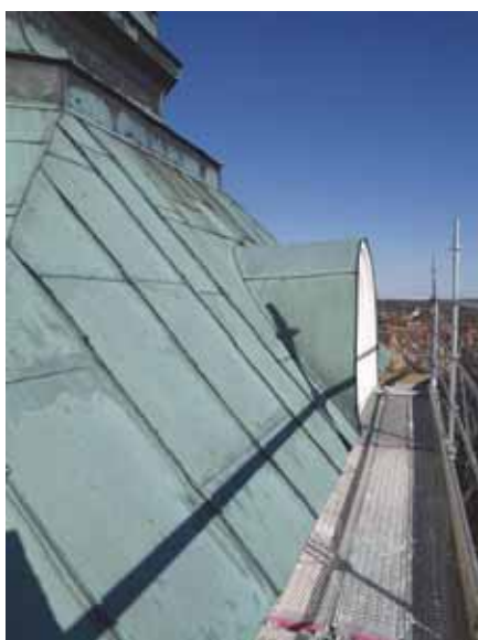
Ett av torntaket takfall före åtgärderna. VGM_jenbj8_Tidaholms_kyrka_puts_o_plat_2013-04-08_3.jpeg
