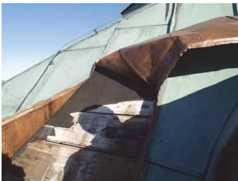
Under takplåten på tornet före åtgärderna. VGM_jenbj8_Tidaholms_kyrka_puts_o_plat_2013-04-08_2.jpeg
