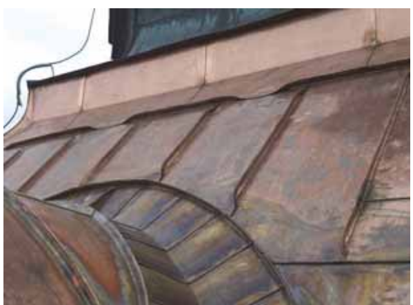
Närbild på plåtarbetet. VGM_jenbj8_Tidaholms_kyrka_puts_o_plat_2013-10-09_2.jpeg
