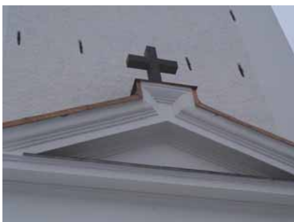
Del av västportalens fronton efter åtgärderna. VGM_jenbj8_Tidaholms_kyrka_puts_o_plat_2013-12-10_2.jpeg
