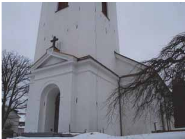
Frontonen på västportalen efter åtgärderna och avfärgningen. VGM_jenbj8_Tidaholms_kyrka_puts_o_plat_2013-12-10_4.jpeg
