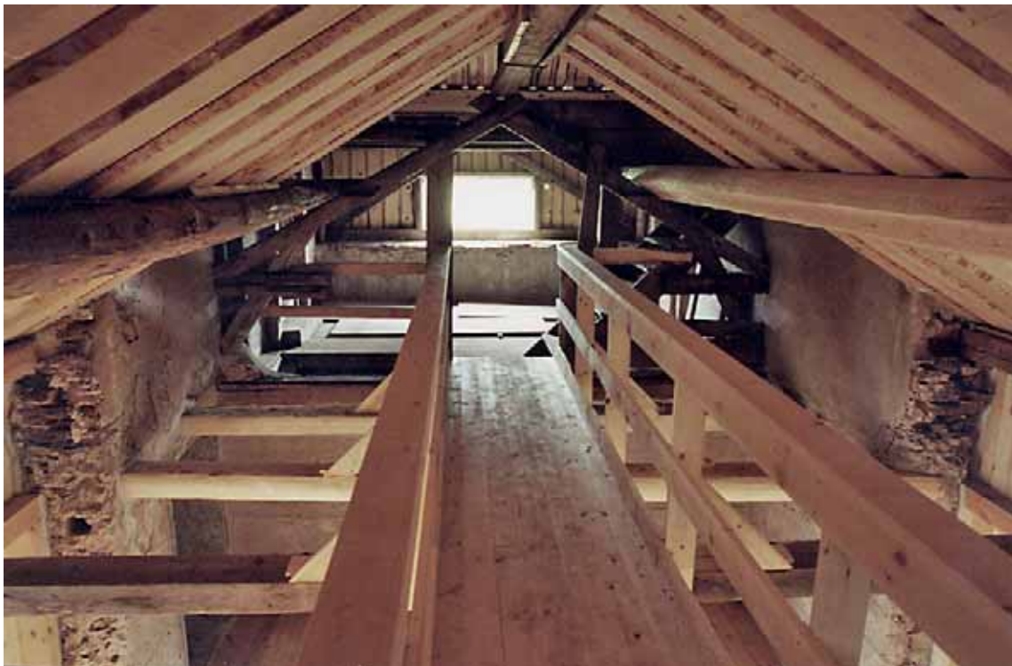
Som ovan. Blick mot öster in i "förstugan" till kölnan. Takstolarna i bakgrunden hade tidigare burit mellanhusets förlängning ut mot öster. Obs resterna av det gamla mellanhusets gjutna väggar. Aug. 2004.
