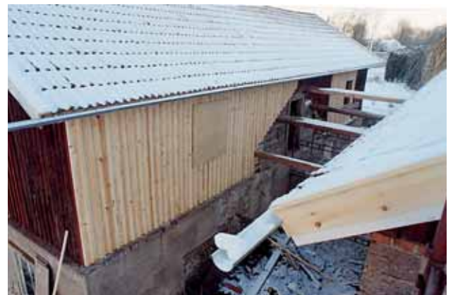
När alla timmerlagningar var avslutade, kläddes husen med ny ramsågad panel och takteget lades tillbaka, med komplettering. Urtag i panelen lämnades för det kommande "mellanhuset". Dec. 2002.
