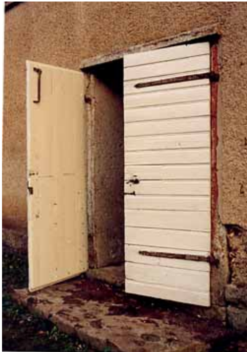
Pardörrarna till västra huset lagade och målade. Okt. 2003.
