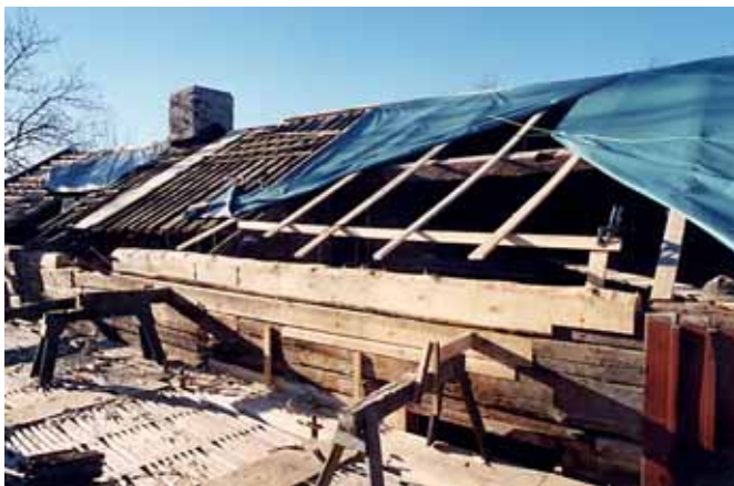
Samma parti av köksväggen (västra huset) - hela väggen upp till hammarbandet byttes. Okt. 2002.
