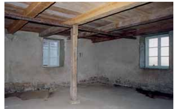
Nordöstra rummet i östra huset med nya bjälkar och huvudsakligen nytt golv. Obs tvärbjälke av begagnad smalspårig järnvägsräls. Nov. -07.
