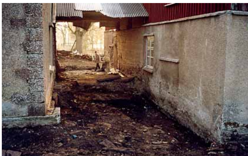
Utrymmet mellan husen klart i väntan på den nya mellanbyggnaden. Okt. 2003.
