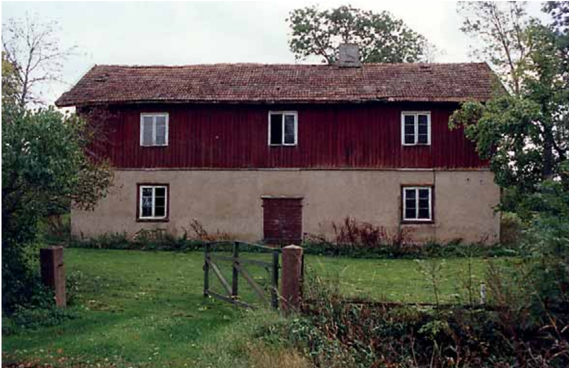
Västerplana mejeri, västra huset, fasad mot landsvägen. Foto okt. 2001.
