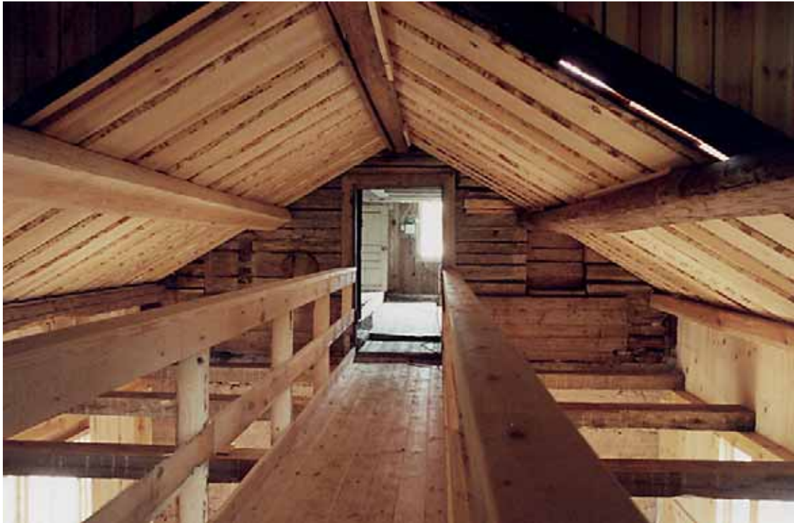
De båda övertvåningarna sammanbinds med en gångbro, för övrigt lämnades bjälklaget utan golv. Blick mot väster in i bostadens förstuga. Aug. 2004.
