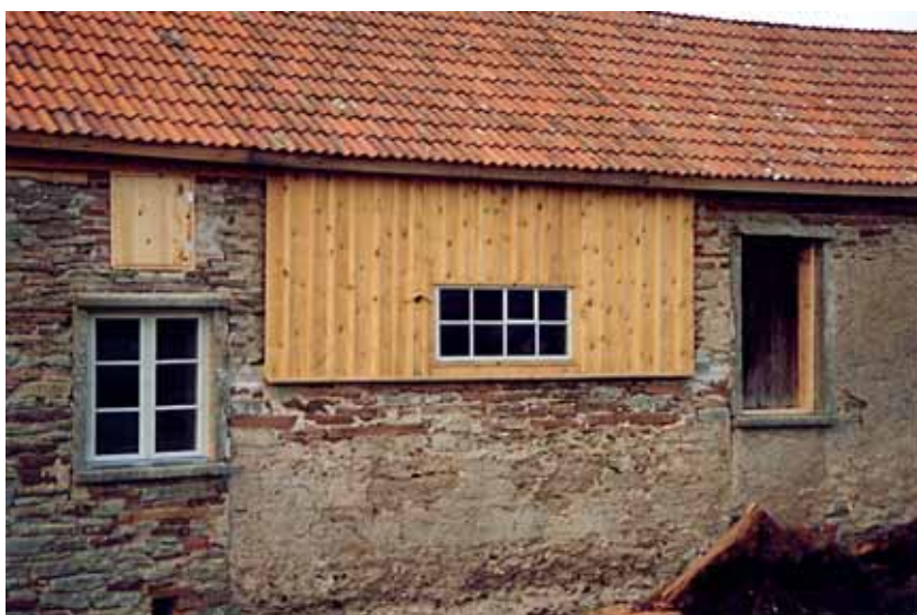
Ny locklistpanel i stället för den gamla som hade fallit sönder. I den monterades ett äldre fönster, tillvarataget från Rörstrands fabriker i Lidköping.
