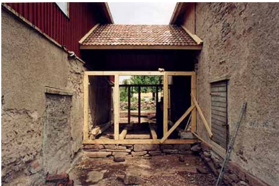
När taket var klart restes stommen till väggarna. På taket lades begagnat tvåkupigt tegel. Ny sockel av kallmurad kalksten. Juni 2004.
