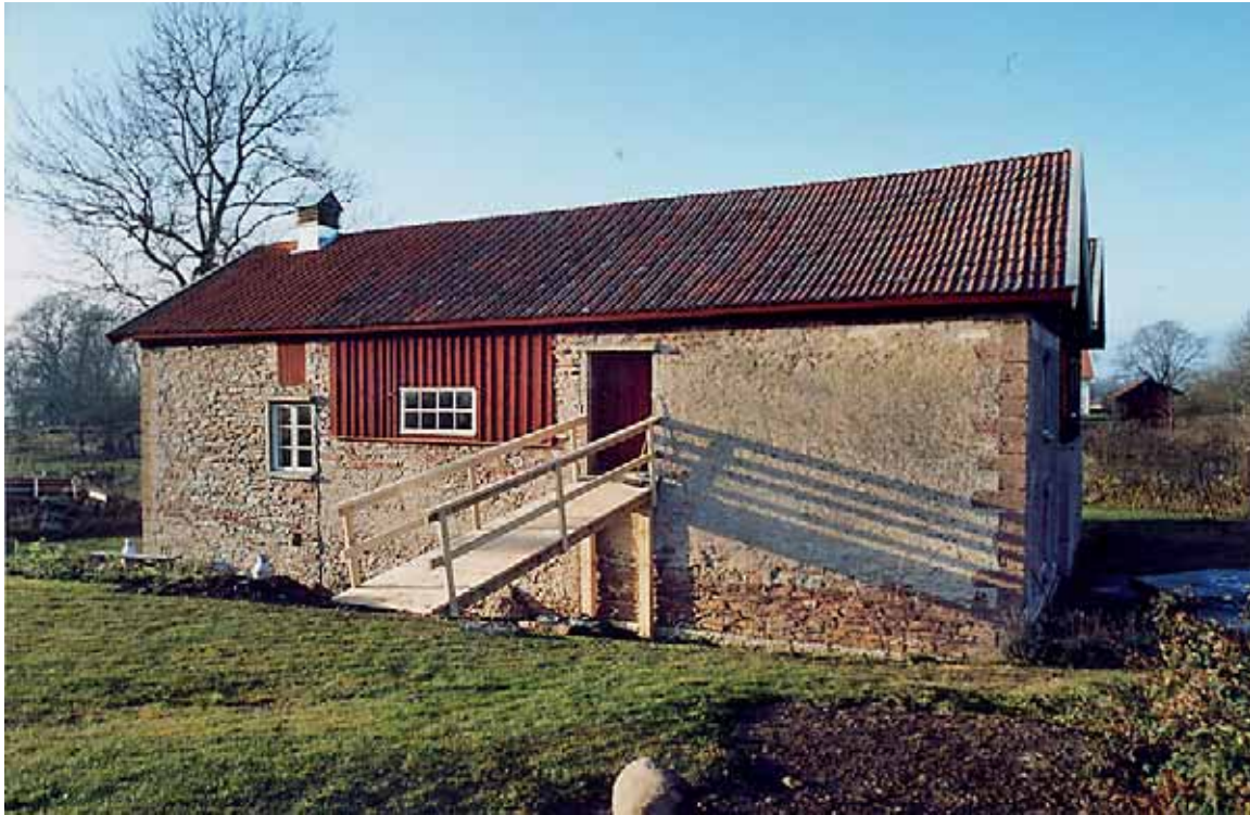
Ett utvändigt nytillskott under hösten 2007 blev en gångbro till norra rummet i övre våningen på östra huset. Nov. -07.
