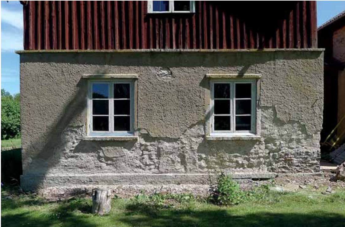
De större bortfallen av gjutmassan kompletterades med skrotsten, varefter utstockningen med kalkbruk baserat på kalk från Kinnekulle lades på i flera tunna skikt. Juli 2012.
