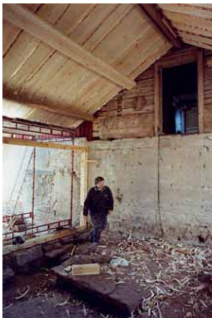
Först byggdes taket på de kvarvarande (och delvis utbytta) åsarna. Juni 2004.
