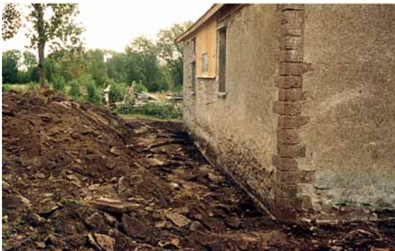
Grävning runt husen för dränering. Mycket vatten rinner periodvis under husen uppifrån berget. Sep. 2003.
