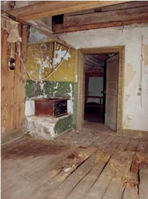
Ovan: Stora rötskador i köksgolvet. Ovan höger: Bräderna demonterades och kasserades i köket. Okt. 2005.
