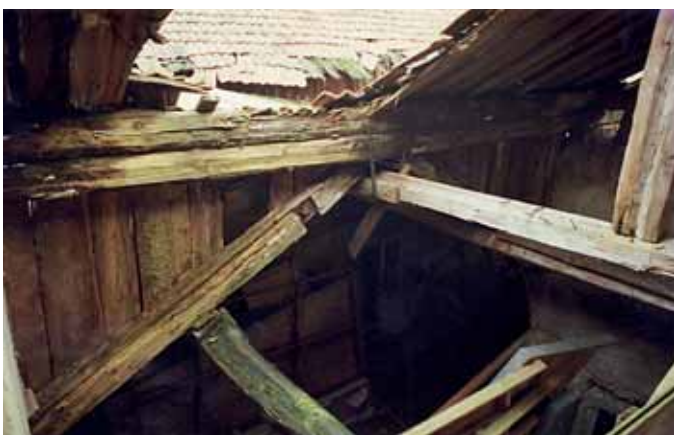
Rester av en gammal takkonstruktion till "mellanbyggnaden" i östra huset. Okt 2001.
