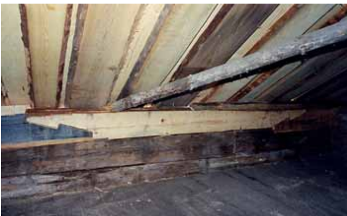
Samma parti som ovan t. höger - förutom hakskarvarna dymlas skarvarna i hammarbandet för extra styrka. Nov 2002.
