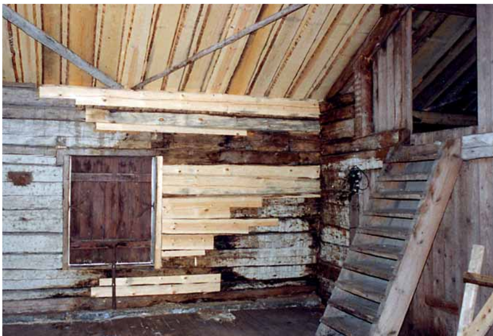
Väggen timrades upp på nytt med nytt timmer. Det nya taket sett underifrån. Nov. 2002.
