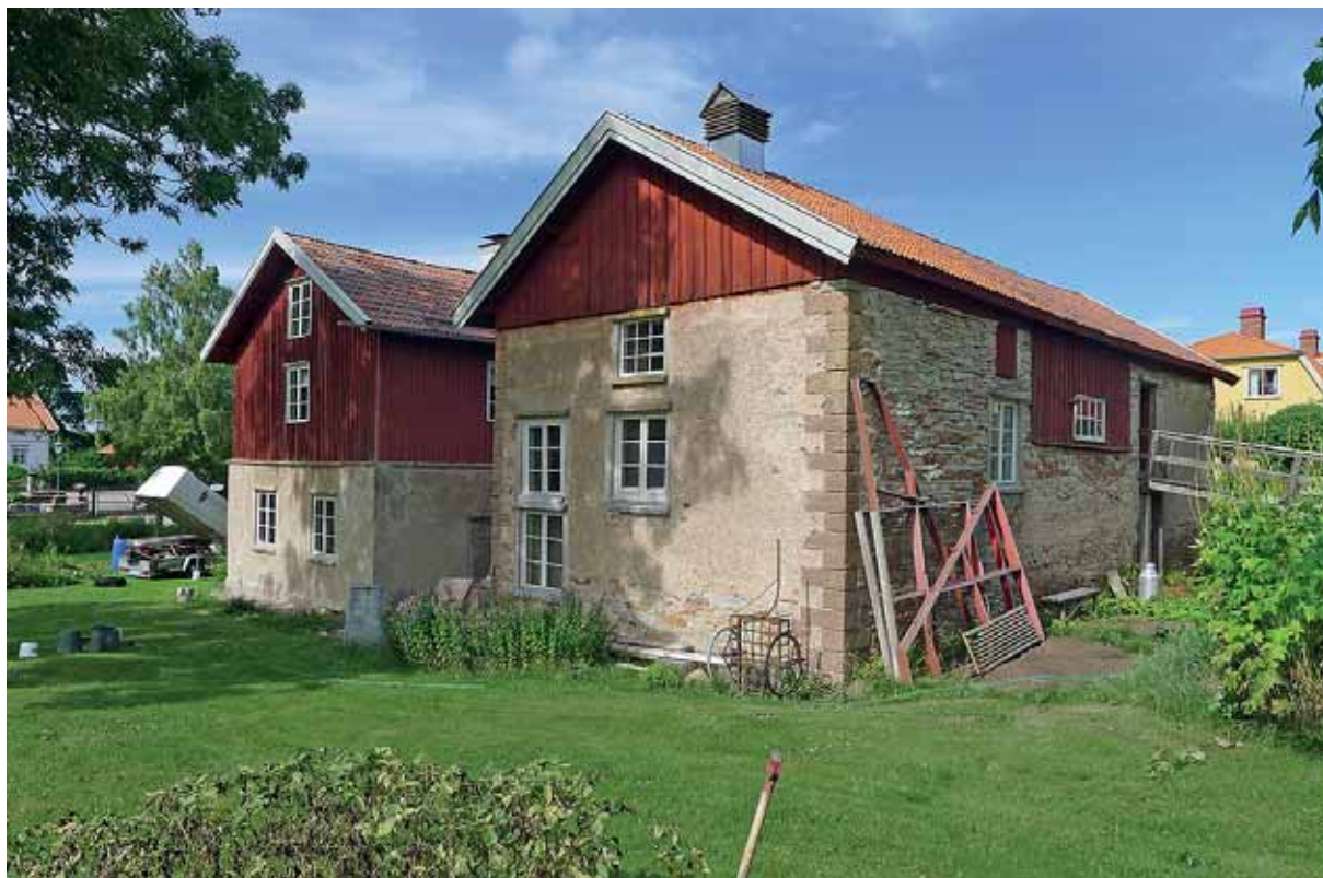
Mejeriet från sydost i slutfasen av renoveringsarbetena. Aug 2012.
