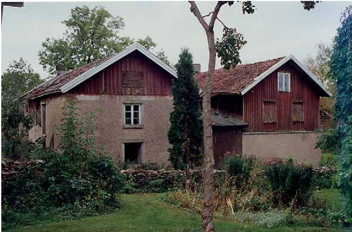
Västerplana mejeri från N, th det gjutna huset med mejeri, magasin och bostad, tv huset med blå kölnan. Foto okt. 2001.
