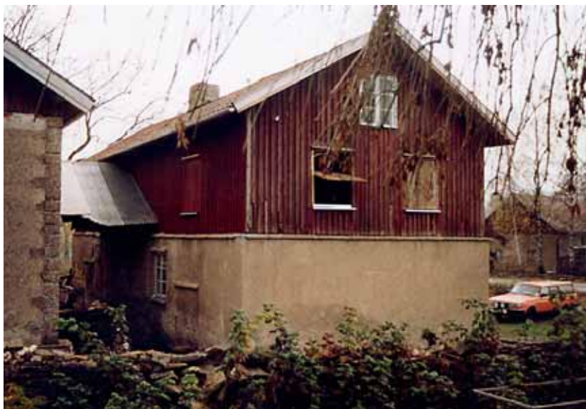
Norra gaveln med luckorna till magasinet efter renovering. Okt. 2003.
