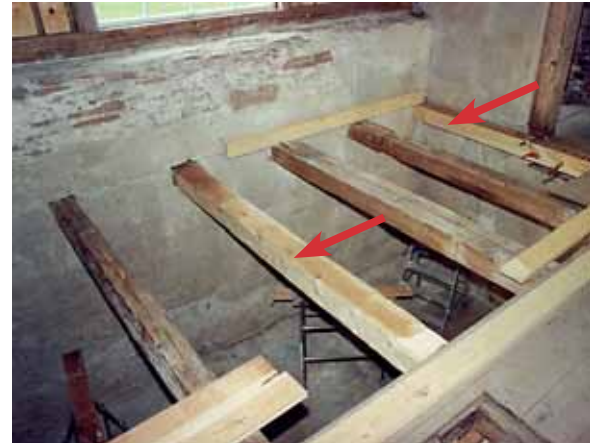
Nya bjälkar vid pilarna. Sept. -07
