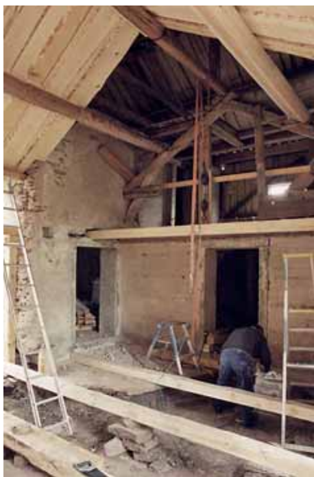
Samtidigt lades nya golvbjälkar. Juni 2004.
