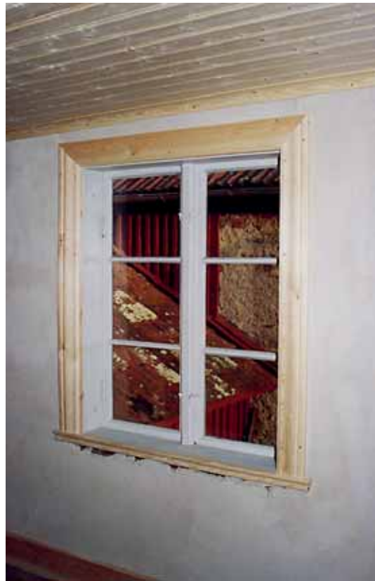
Vänster: Mattias Forsberg monterar nytt tak av pärlspånt i köket. Lasse Dahlberg övervakar. Okt. -06. Höger: Kökets yttervägg kalkputsades och fönsterfoder monterades. Nov. -06.
