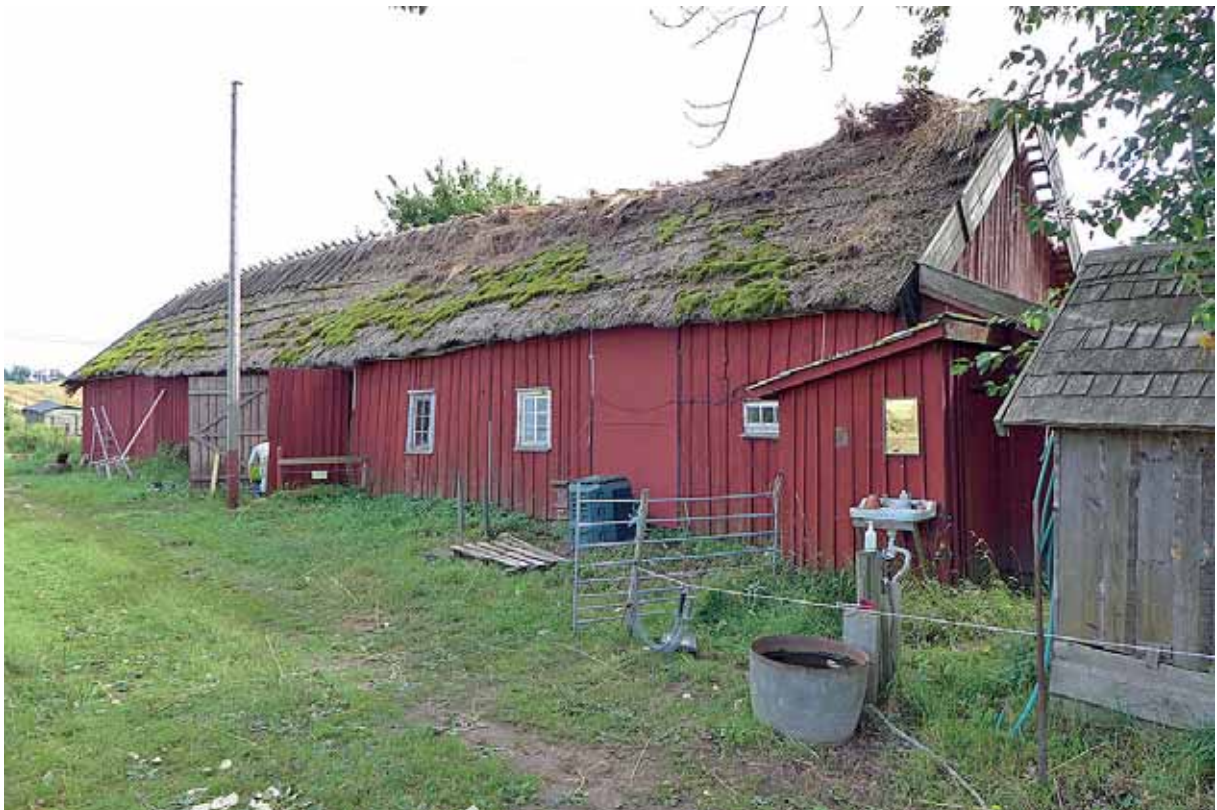
Det norra takfallet inför omläggning, 2013-08-20. Lägg märke till mossan på taket. Foto: Ulf Larsson.
