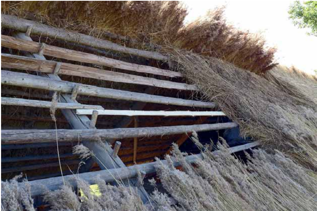
Norra takfallet, 2012-09-03. I bildens högra del syns det parti av äldre halm som sparades under det nya vasslagret. Notera även de s.k. "räftepinnarna" på sparren i bildens vänstra del, som räfterna vilar på. Foto: Ulf Larsson.
