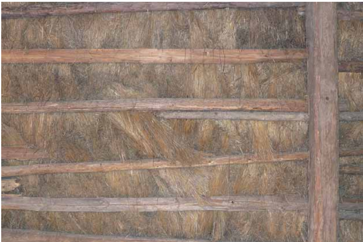
Det gamla halmlagret på norra takfallet sett inifrån körlogen, 2013-08-29. Lägg märke till den relativt oordnade läggningen. Foto: Ulf Larsson.
