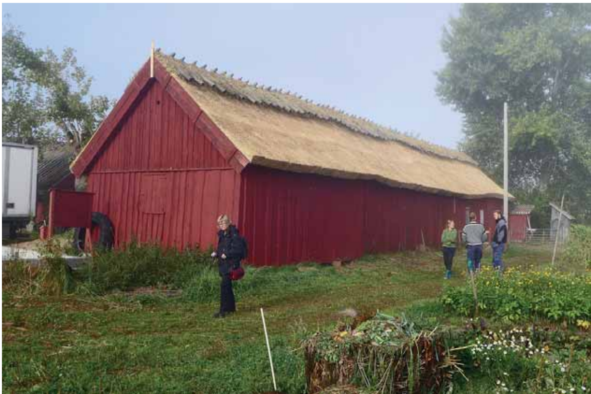
Ladugården från nordost i samband med slutbesiktningen, 2013-09-11. Lägg märke till hur den något böljande takfoten anpassats till byggnadens stomme. Foto: Ulf Larsson.
