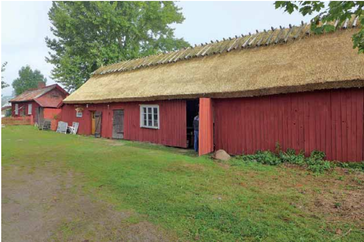
Det södra takfallet efter färdigställd omläggning, 2013-09-11. Foto: Ulf Larsson.
