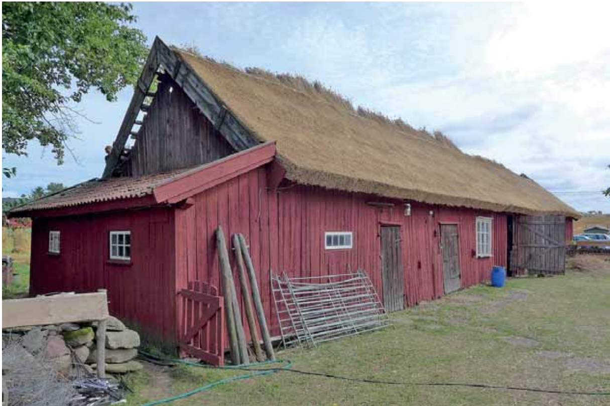
Det södra takfallet efter färdigställd omläggning, 2013-08-29. Foto: Ulf Larsson.
