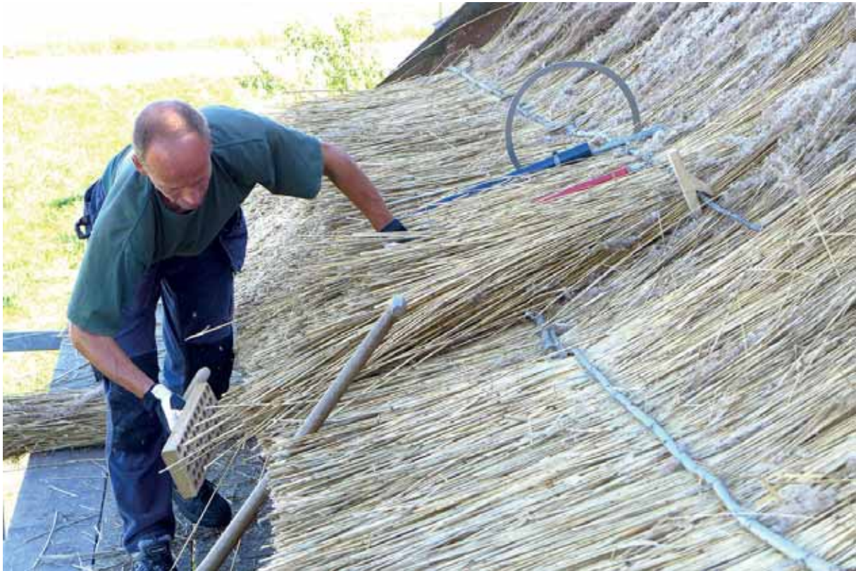
Omläggning av det norra takfallet pågår, 2013-09-03. I bildens övre del syns den cirkelformade krumnål som användes till bindning av huvuddelen av taktorna. Foto: Ulf Larsson.
