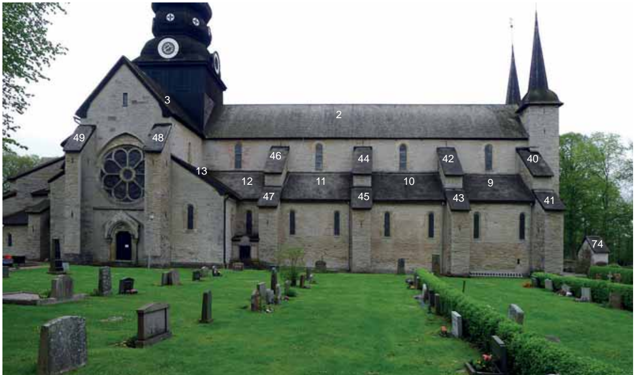
Kyrkan sedd från norr före 2014 års arbeten, med numrerade tak. Maj 2014.
