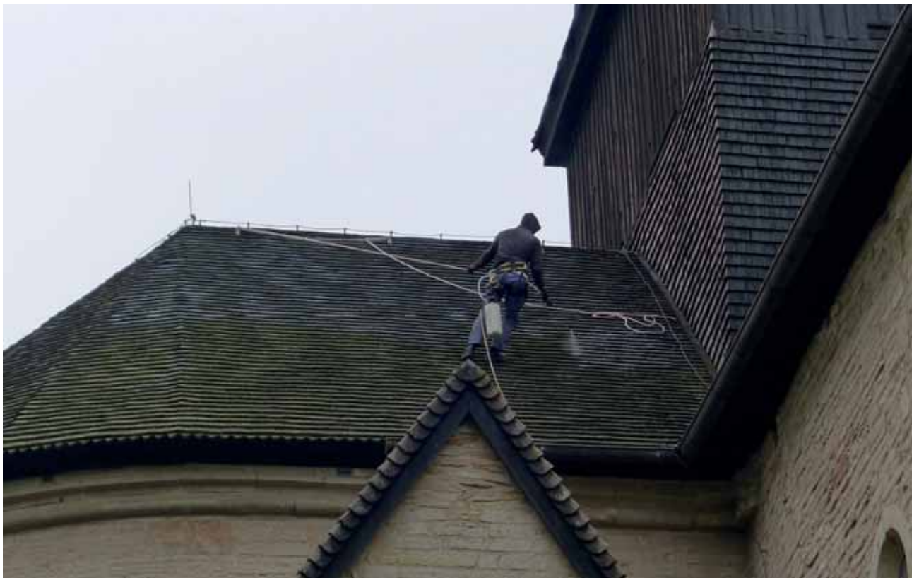
Tak nr 5 över koret, sprutning med Grön-Fri algvätt före tjärbehandling. Maj 2014.
