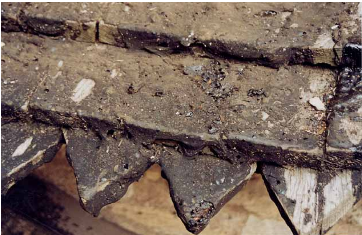
Tak 32, detalj av ovan. Stenkolstjären hade bildat ett tätt skal under vilket spånen ruttnade. Aug. 2004.
