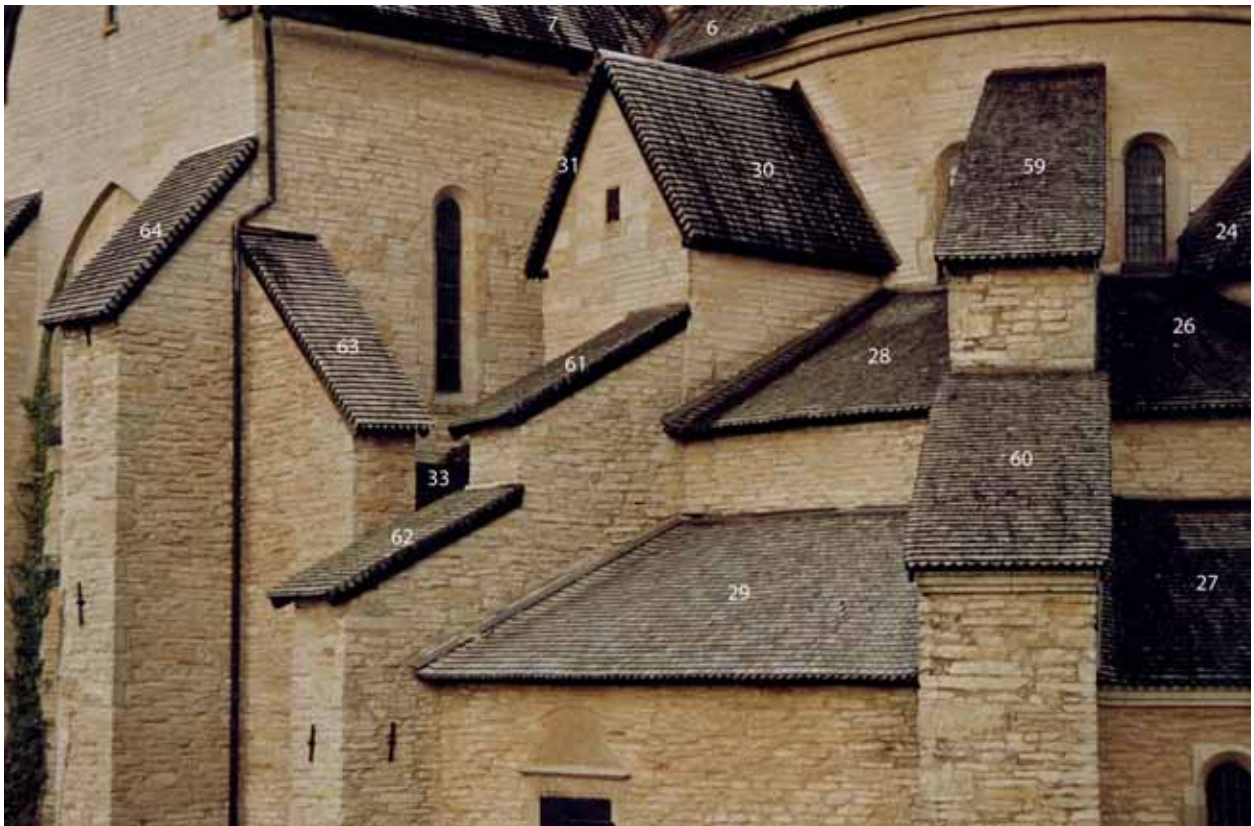
Tvårskepp, kor, koromgång och gravkapell sedda från SO med numrerade tak. Dec. 2003.
