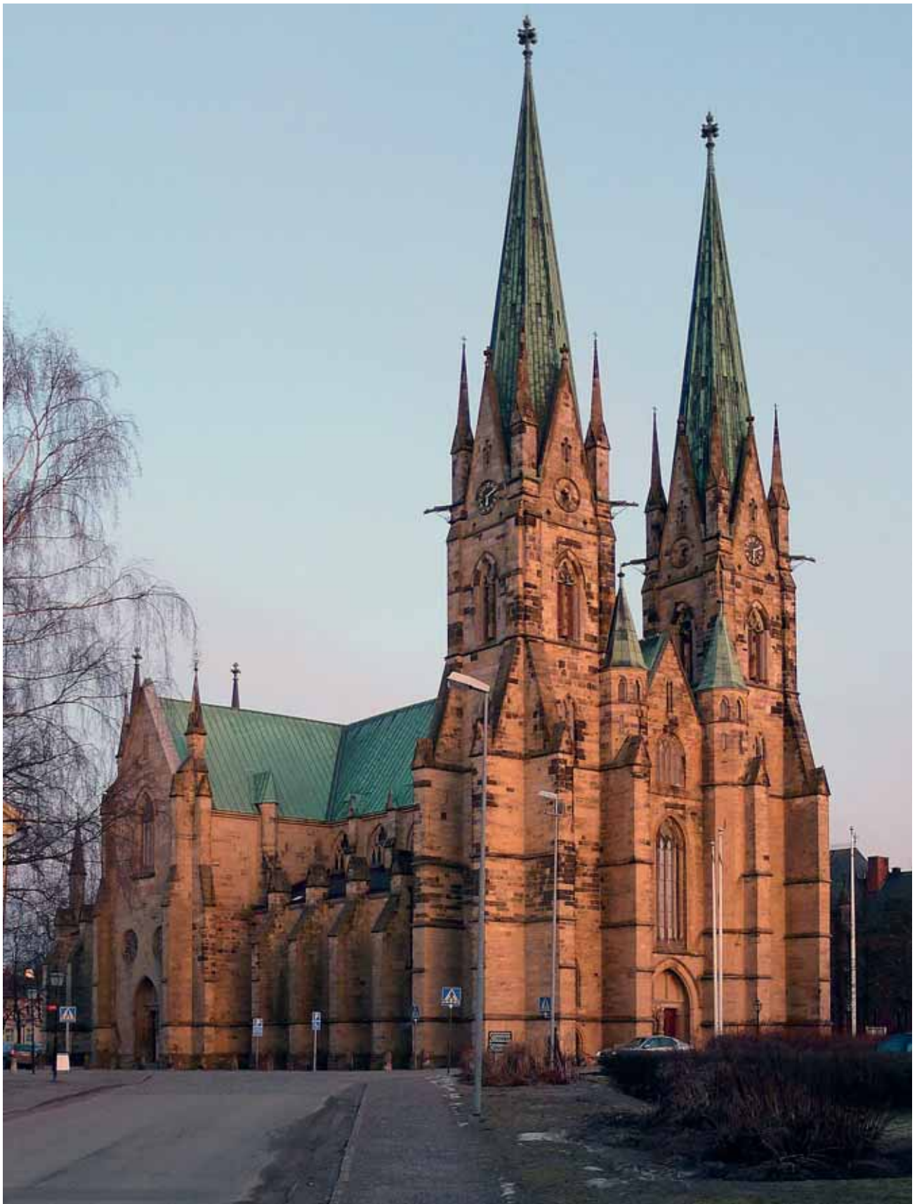
Skara domkyrka sedd i kvällssol från NV före arbetena på tornen. Foto mars 2011.
