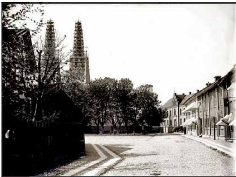
Domkyrkan i slutfasen av restaureringen 1886 - 1894, båda spirorna var då nybyggda. Bilden sedd från Skolgatan mot väster. VGM bildarkiv.
