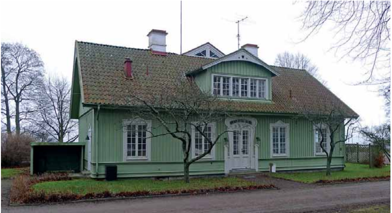
Villa Idun, fasad mot väster. Jan 2013.
