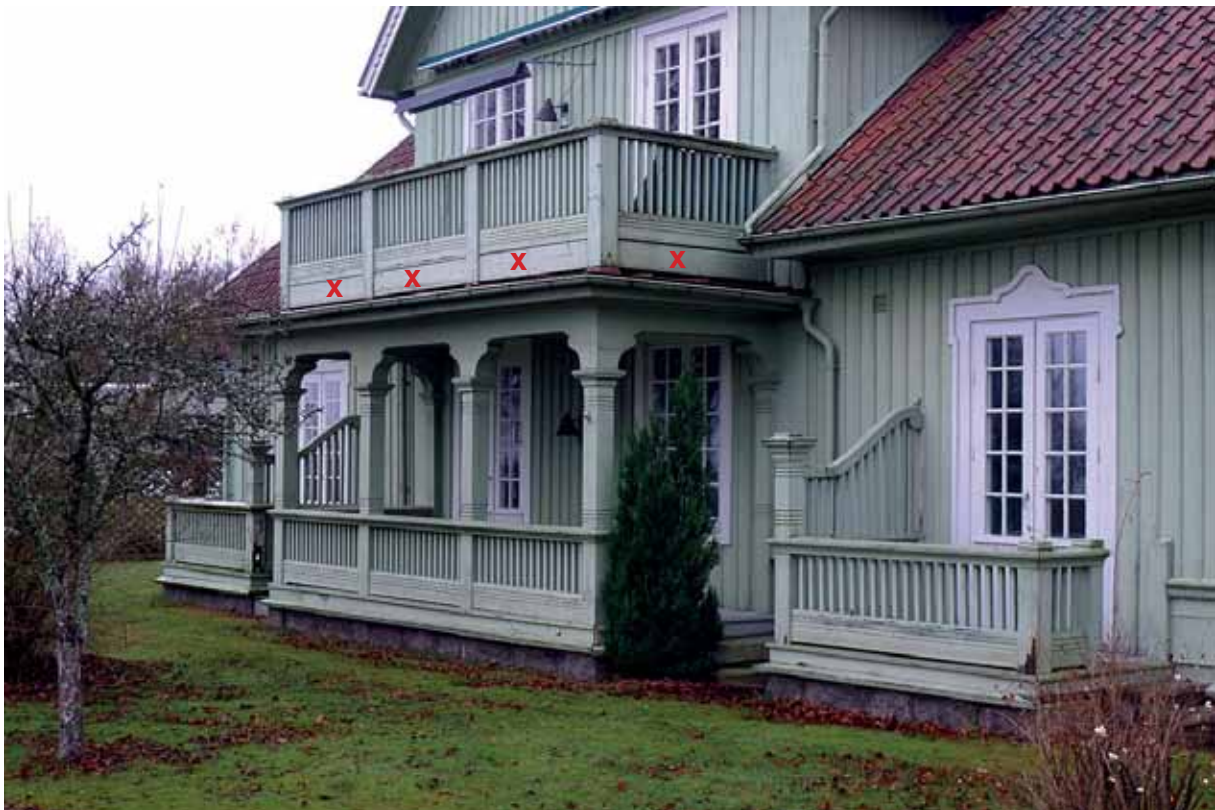
Villa Idun före renoveringen. Veranda/altaner mot sjön och balkong med ca 1960 förhöjt räcke. Delarna märkta X utgör förhöjningen. Jan. 2013.
