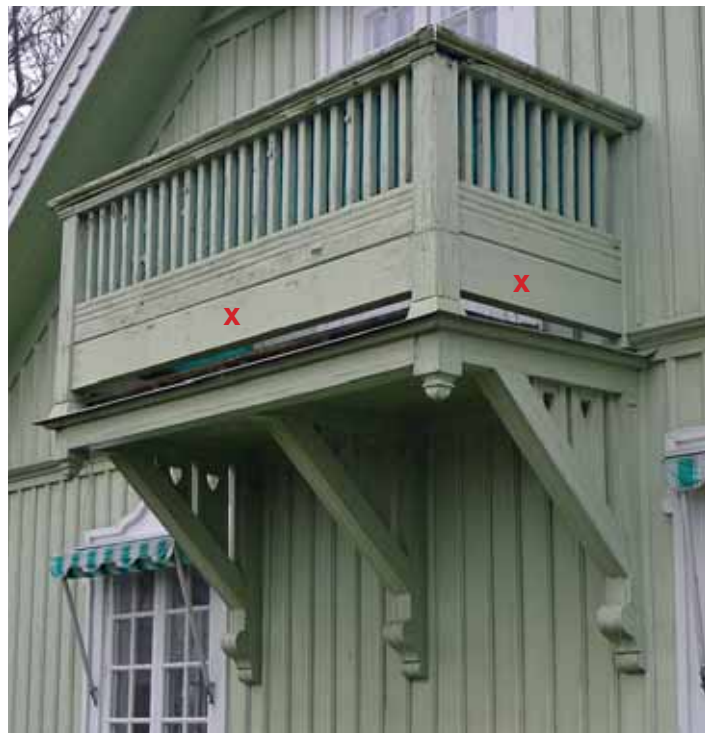
Höger: Villa Idun, balkong mot söder med förhöjt räcke från ca 1960. Delarna märkta X utgör förhöjningen. Jan. 2013.
