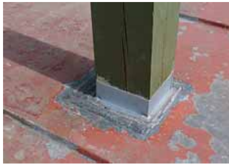
Räckesstolparna på balkongen hade stått på små plintar av plåt. Nya tillverkades av galvad plåt. April 2015.
