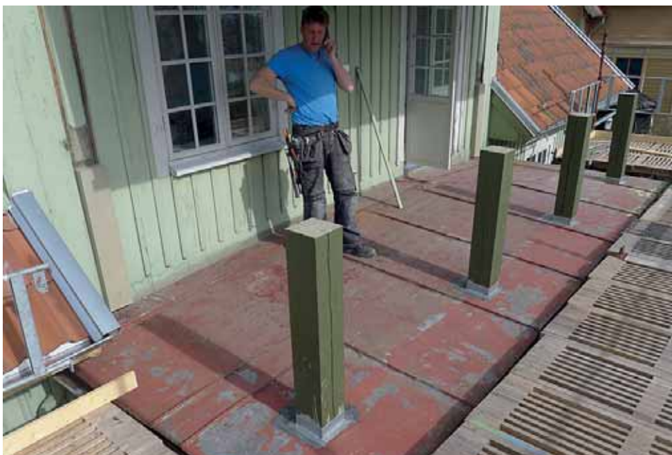
Stolparna monterade på övre balkongen. All plåt rostskyddsmålades därefter. April 2015.
