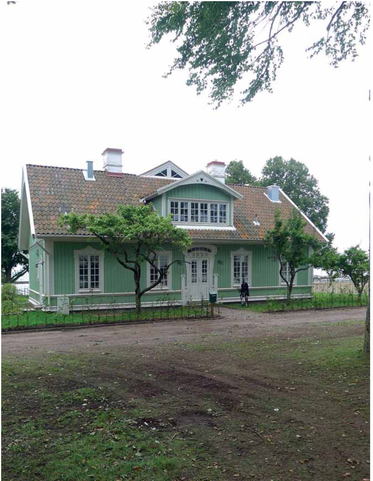
Villa Idun, fasad mot väster efter renovering. Sept.2015.
