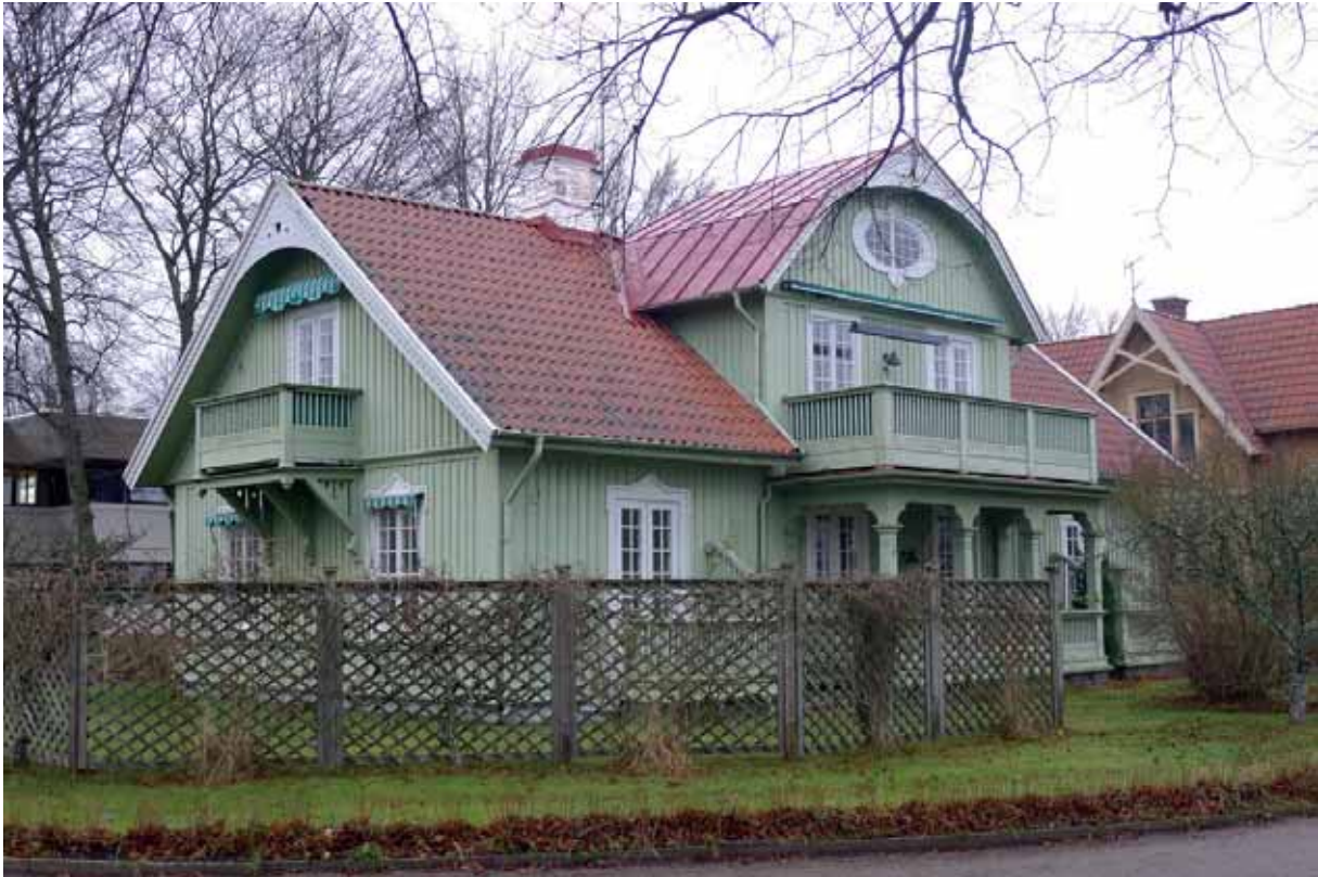
Villa Idun från SO före renoveringen. Jan.2013.
