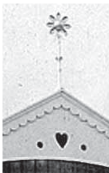
Vänster: detalj av foto ca 1905 med ”blomma” av plåt på frontens nack.
