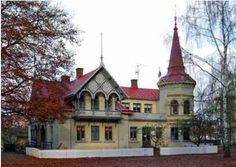
Villa Götha efter putsrenovering och målning av tak och fönster. Foto nov. 2013.
