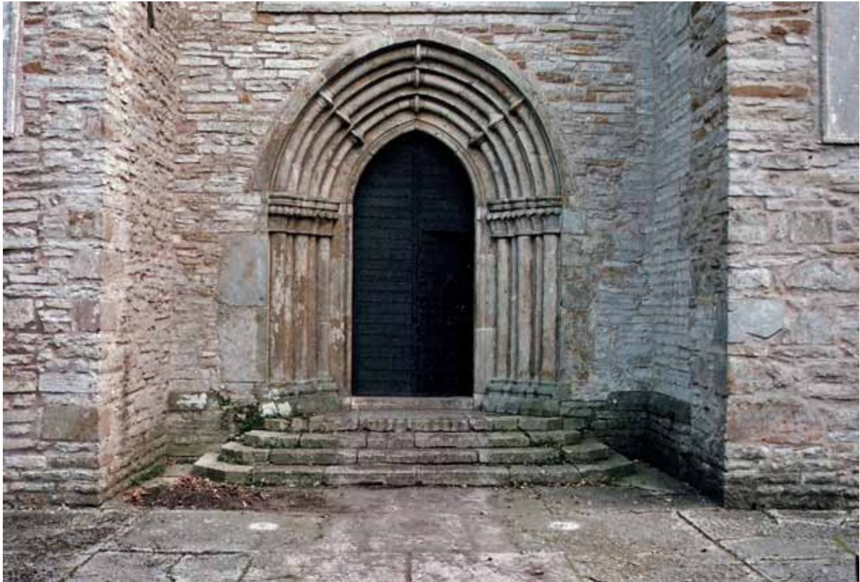
Rampen borttagen inför renoveringsarbetena. Detta var entrén under närmare 90 år. Foto okt. 2010.
