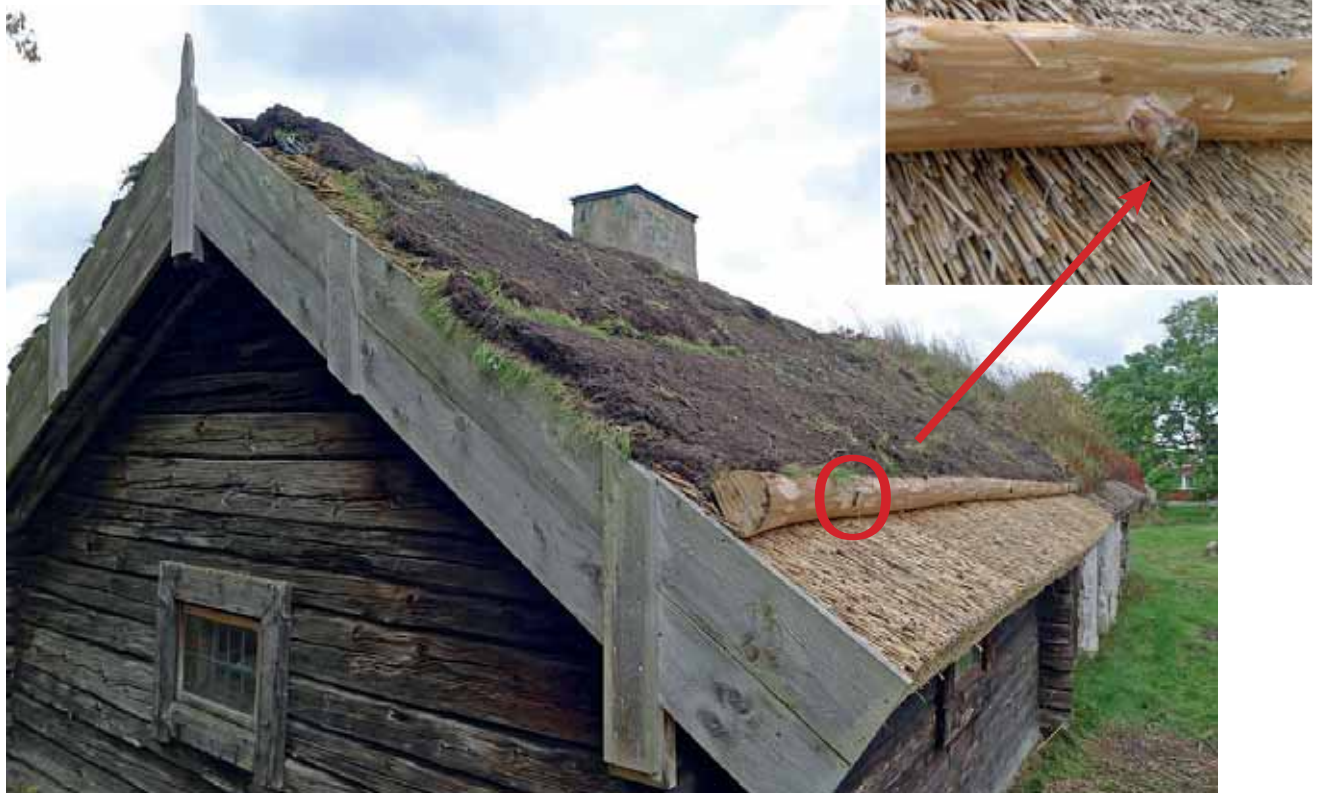
Mullstockarna hålls fast in i vasstaket genom ungefär meterlånga grangrenar, synliga som en träangel i mullstocken. Tre på varje sida. 12 okt. 2015.
