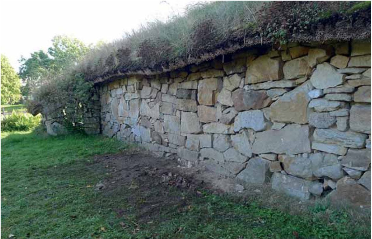
Murpartiet återuppfört. sept. 2015.
