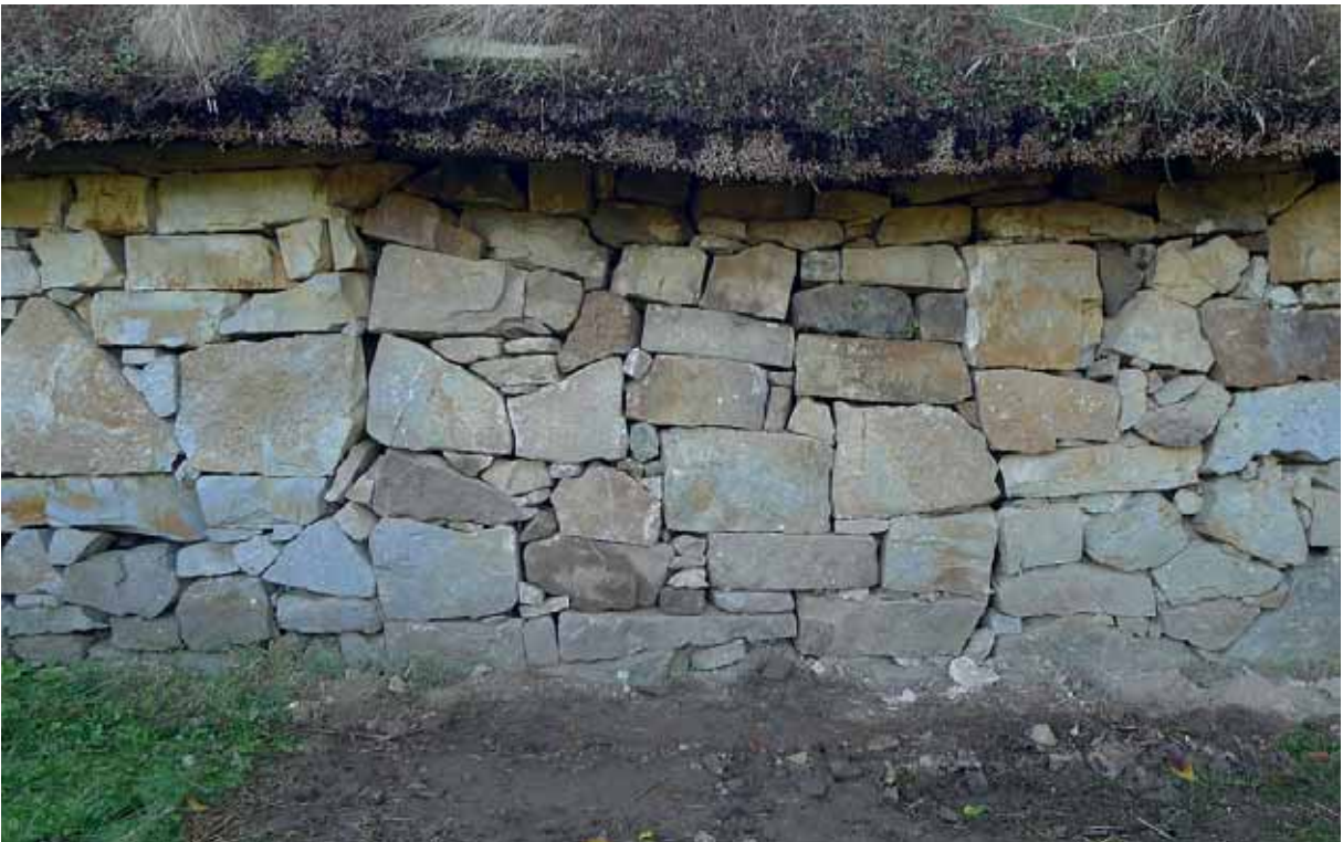
Stenarna i fasad återlades i huvudsak som de tidigare legat. Vissa säkringar gjordes till närliggande murverk. Sept. 2015.
