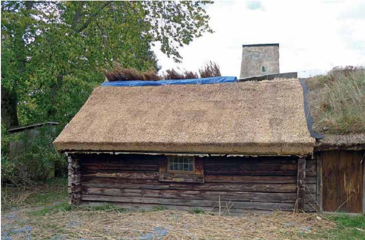
Vasstäckningen på takfallet mot vägen färdigt. 6 okt. 2015.
