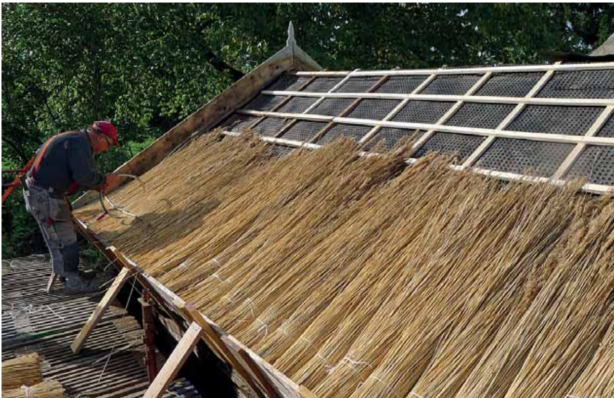
Vassen binds med ståltråd och en specialtillverkad rund nål som når ner under läkten. Det andra lagret vass binds mot täckespröten/hasselkäpparna. 1 okt. 2015.
