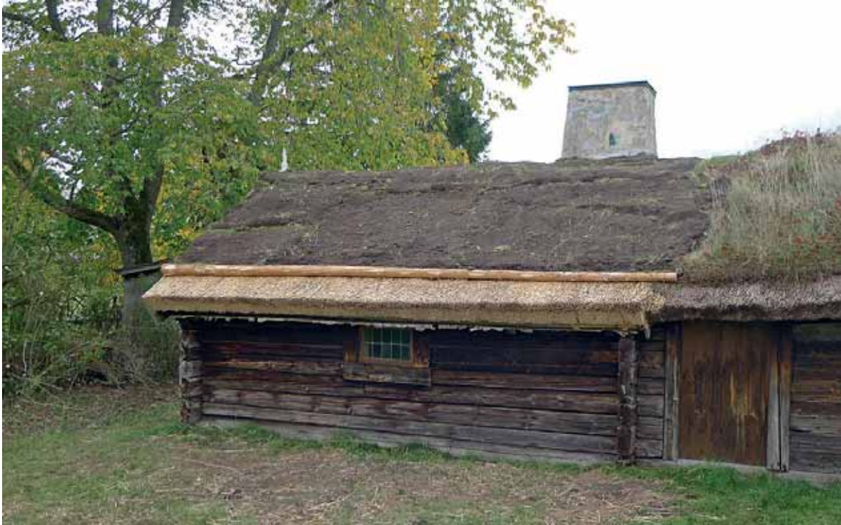
Det första lagret torv med grässvålen nedåt. 12 okt. 2015.
