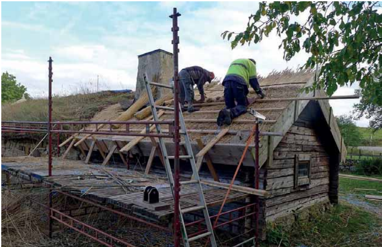
Bengt Rune och Jörgen arbetar med västra takfallets vass. 6 okt. 2015.
