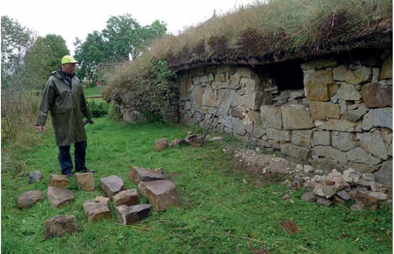
Daniel Larsson i färd med att montera ned murverket. Stenarna lades ut på marken i ordning för att återmuras i så gott det gick ursprungliga lägen. Sept. 2015.
