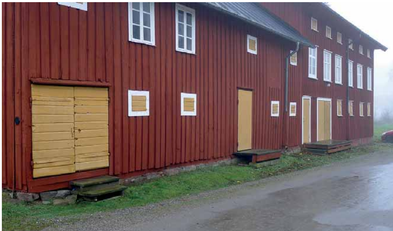
Bengtssonska magasinet, fasad med ingångar, yttertrappor och lastbryggor mot öster före arbetena. Foto nov. 2014.
