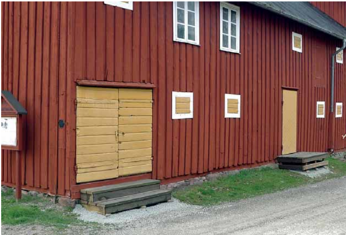
Den närmaste trappan förlängdes med återvänt virke så att den täcker båda dörrbladen. Lilla lastbryggan till höger av samma typ som den större, också nybyggd utan inslag av betong. 24 april 2015.
