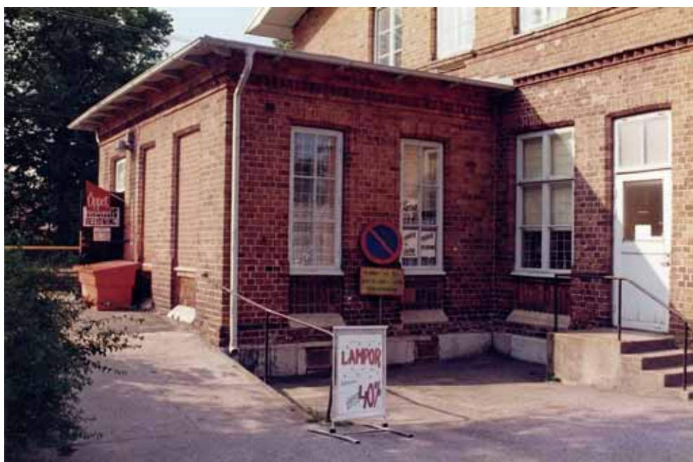
Endast de små utbyggnaderna på gavlarna hade undgått ändringar i takfoten. Aug. 1996.
