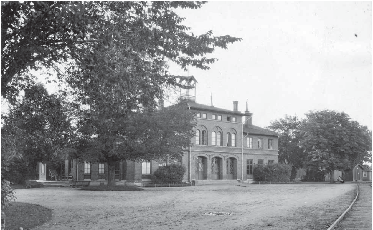
Järnvägsstationen, fasad mot Göta kanal. Lastkajen t.h. utanför bild (se sid. 6), kunde nås av ett alltjämt kvarliggande stickspår. Foto Hartman 1921 i VGM.
