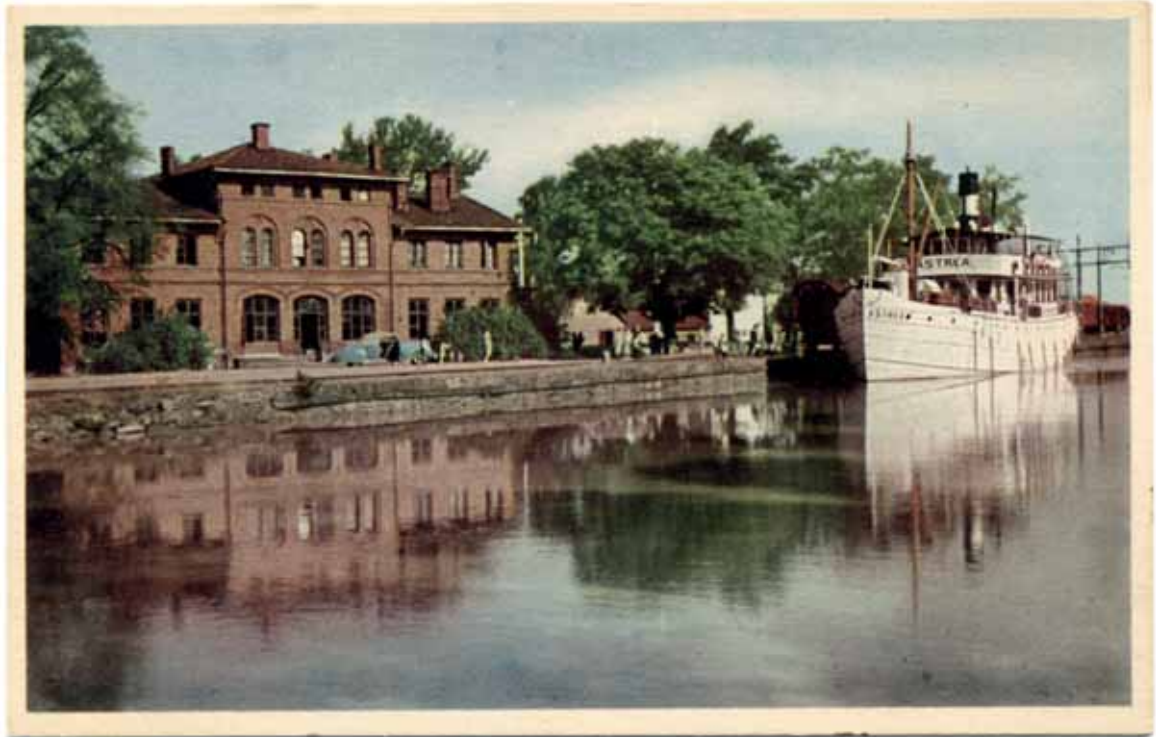
Stationshuset i Töreboda med ångf. Astrea troligen i slutet av 1930-talet. Takryttaren är borta, men flera skorstenar står kvar. Entrépartiet mot kanalen har moderniserats. Vykort.
