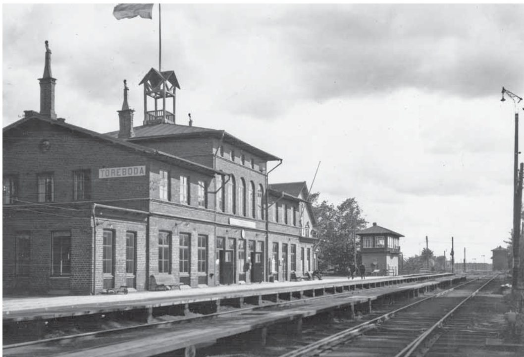
Töreboda station med ställverket, byggt 1915 och rivet 1997. Notera taktäckningen av listtäckt papp på stationshuset, som på 1890-talet ersatte skiffertaket, och i slutet av 1920-talet täcktes av nuvarande tegeltak. Foto Hartman 1921 i VGM bildarkiv.
