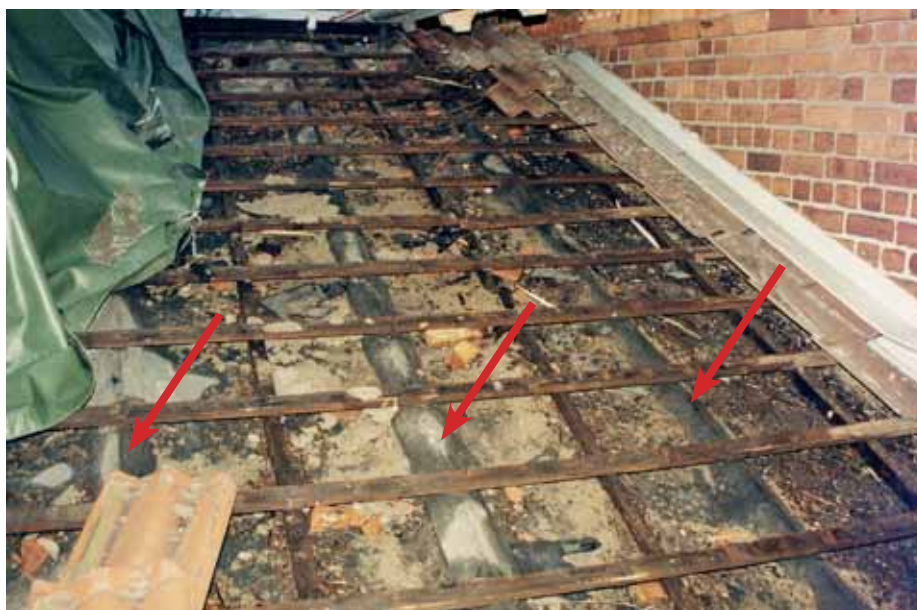
Taket var i gott skick och synbarligen tätt. Därför behövde aldrig panel och papp läggas om. Endast rensning och rengöring. Notera det listtäckta papptaket från omkring 1890 med trekantslisterna, som senare tjänat som ströläkt. Dec. 1996.
