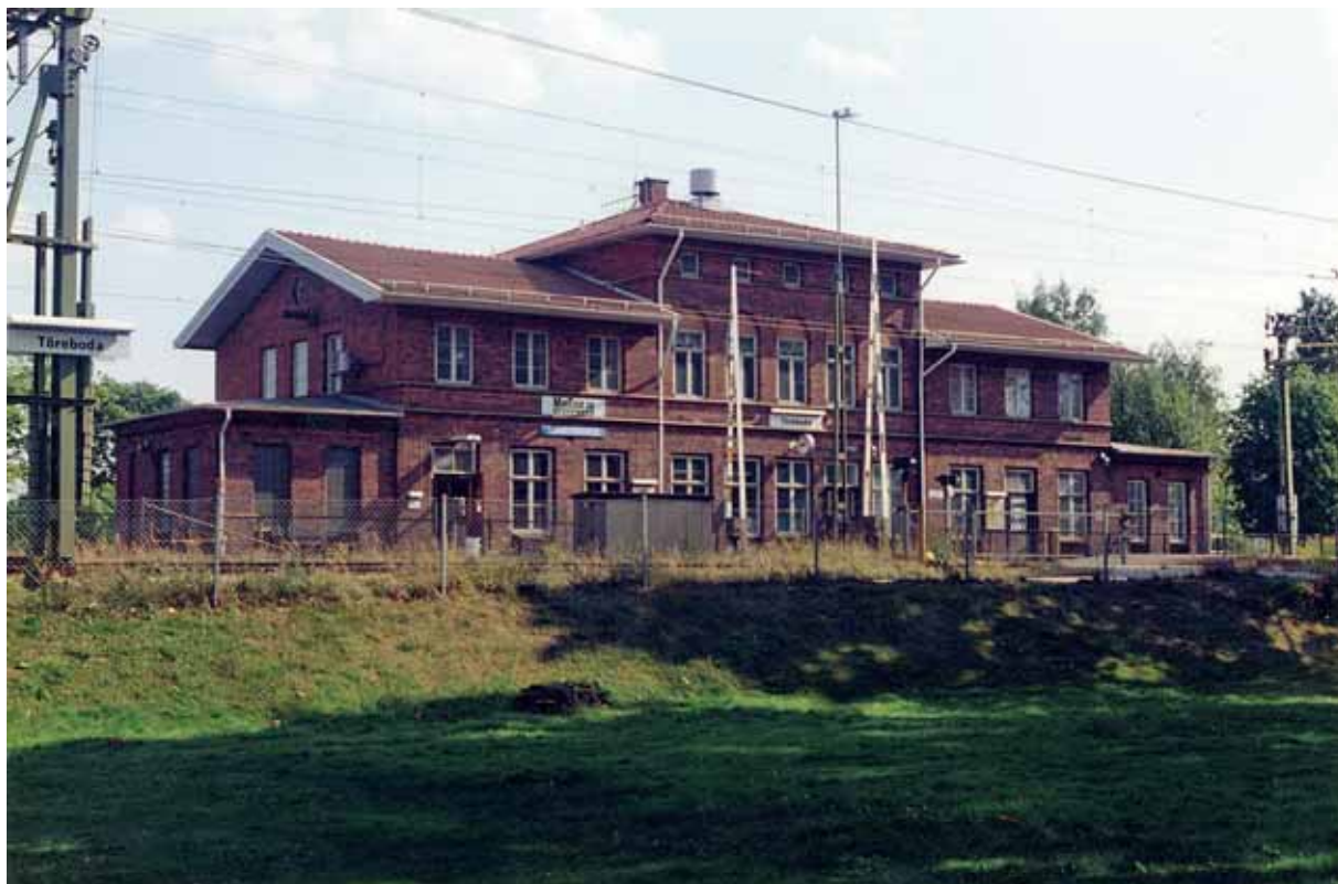
Stationshuset sett från Kungsgatan i aug. 1996. En (sekundär) skorsten återstår, flankerad av en rund ventilationshuv av plåt.
