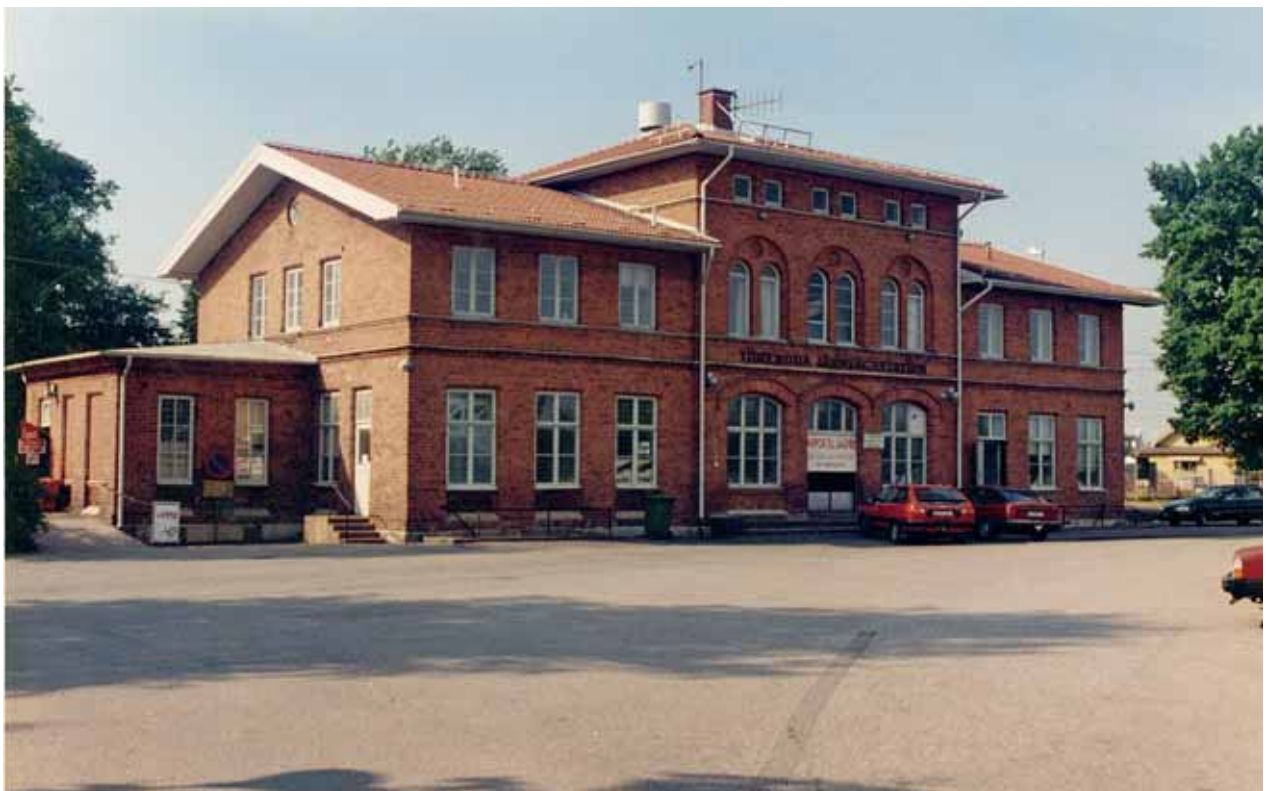
Töreboda järnvägsstation alldeles innan restaureringsarbetena började. Planen mellan byggnaden och kanalen har alltid varit grusad. Aug. 1996.
