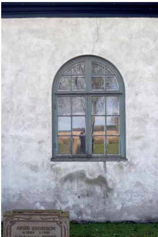
Vänster: Sydfasaden med missfärgad puts. Höger: Tornluckorna var i stort behov av justering och delvis nytillverkning. 2 april resp. 6 maj 2015.
