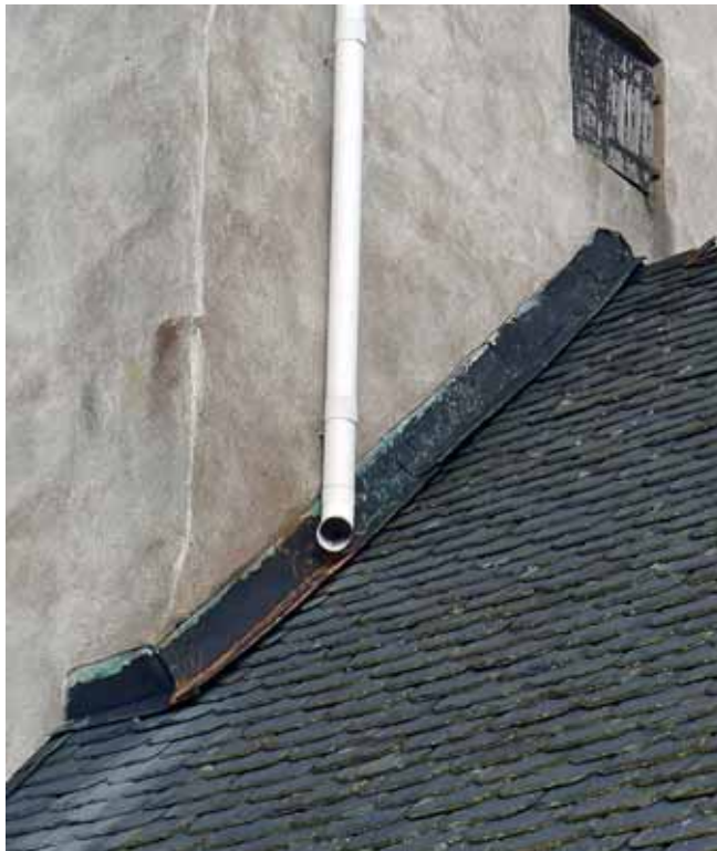
Vänster: Tidigare beslag och stuprör av järnplåt, målade i olika färger. Höger: All plåt byttes nu till zinkplåt som lämnas omålad. 2 april resp. 3 juni 2015.
