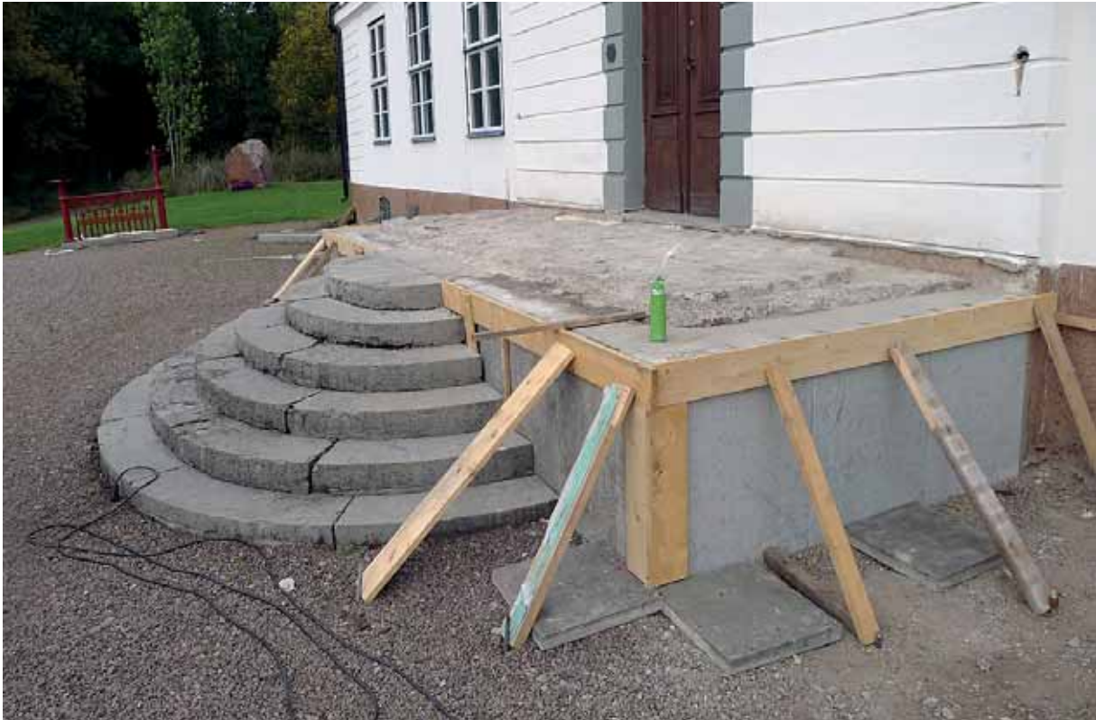
Ovan: Terrassens sidostycken monterade. Okt. 2015. Nedan: Alla delar av gjutjärnsräcket rengjordes och målades med rostskyddsfärg. Räcket är en byggsats av mindre delar som sammanfogas med tappar. 2 Okt. 2015.
