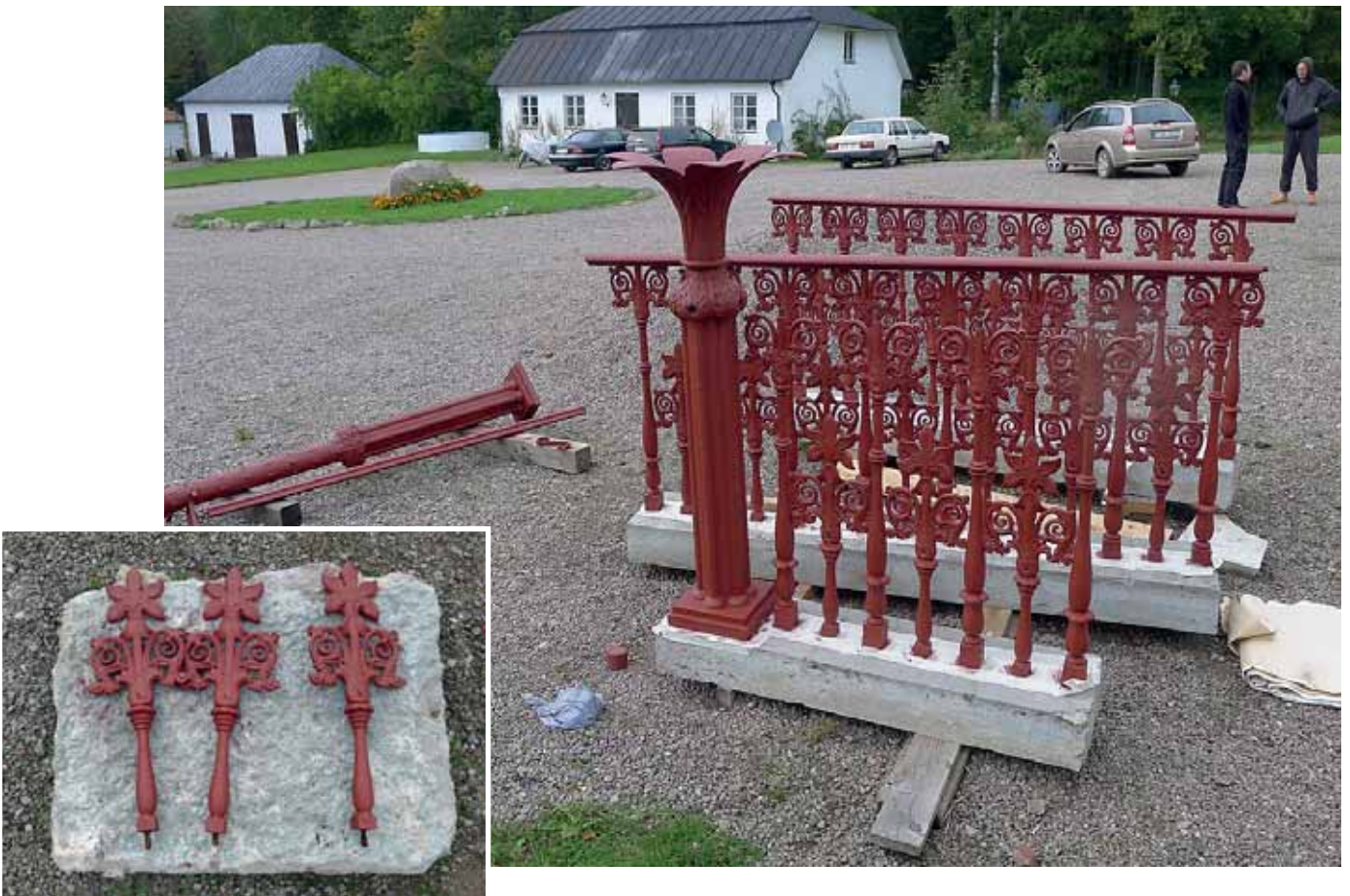
Ovan: Terrassens sidostycken monterade. Okt. 2015. Nedan: Alla delar av gjutjärnsräcket rengjordes och målades med rostskyddsfärg. Räcket är en byggsats av mindre delar som sammanfogas med tappar. 2 Okt. 2015.
