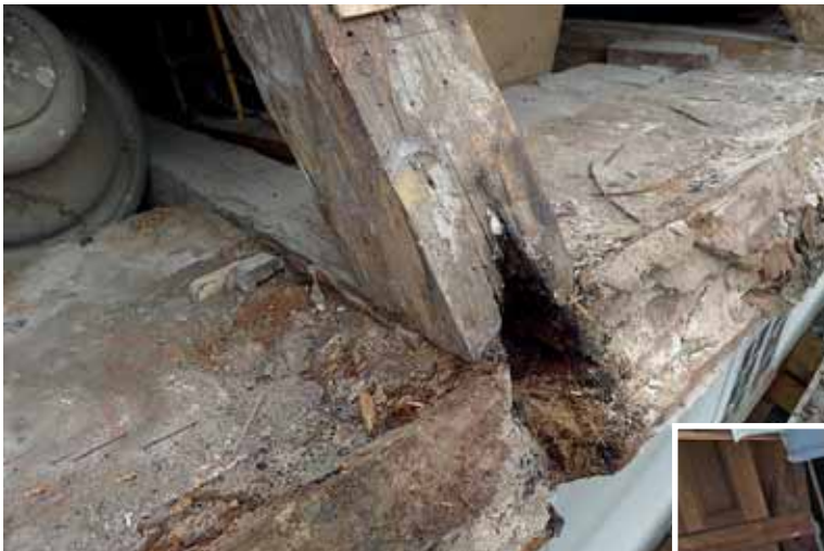
Nedre delarna av flera högben, liksom motsvarande tassar, hade rötskador som bara kan åtgärdas utifrån. Aug. 2015.
