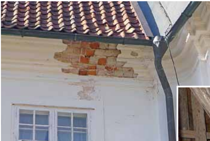
Ovan och höger: Skadan i taklisten berodde på en rötskada i underliggande takpanel. April 2013.
