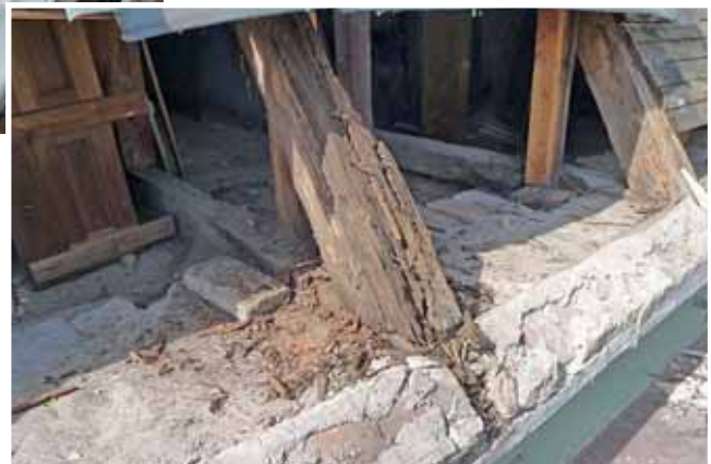
Nedre delarna av flera högben, liksom motsvarande tassar, hade rötskador som bara kan åtgärdas utifrån. Aug. 2015.
