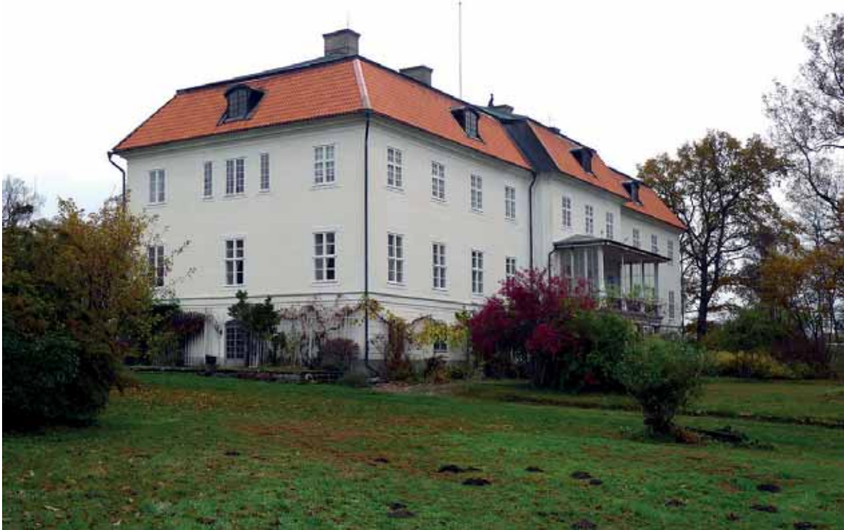
Almnäs huvudbyggnad efter tak- och fönsterarbetenas avslutande. Sjösidan med detalj av det restaurerade partiet av takfoten. 4. nov. 2015.
