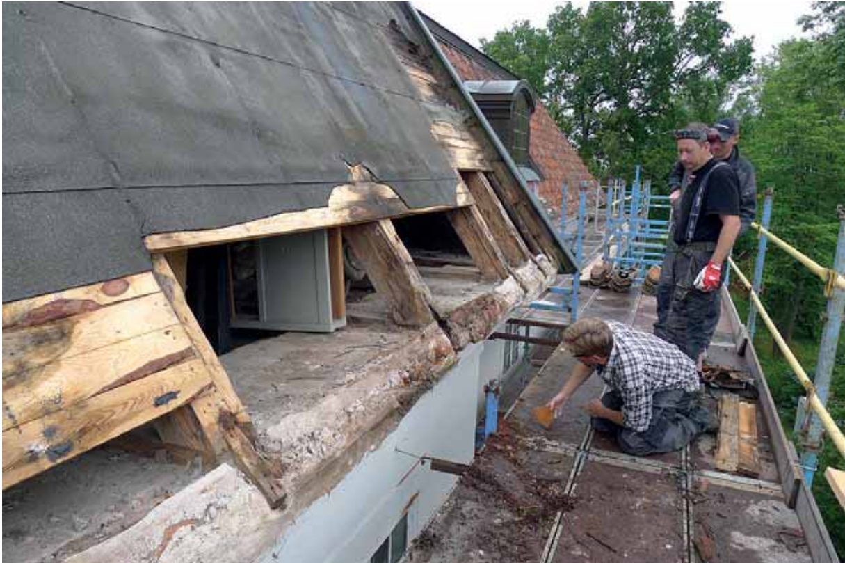
Takfoten i risaliten öppnad för inspektion av takstolarna. Aug. 2015.
