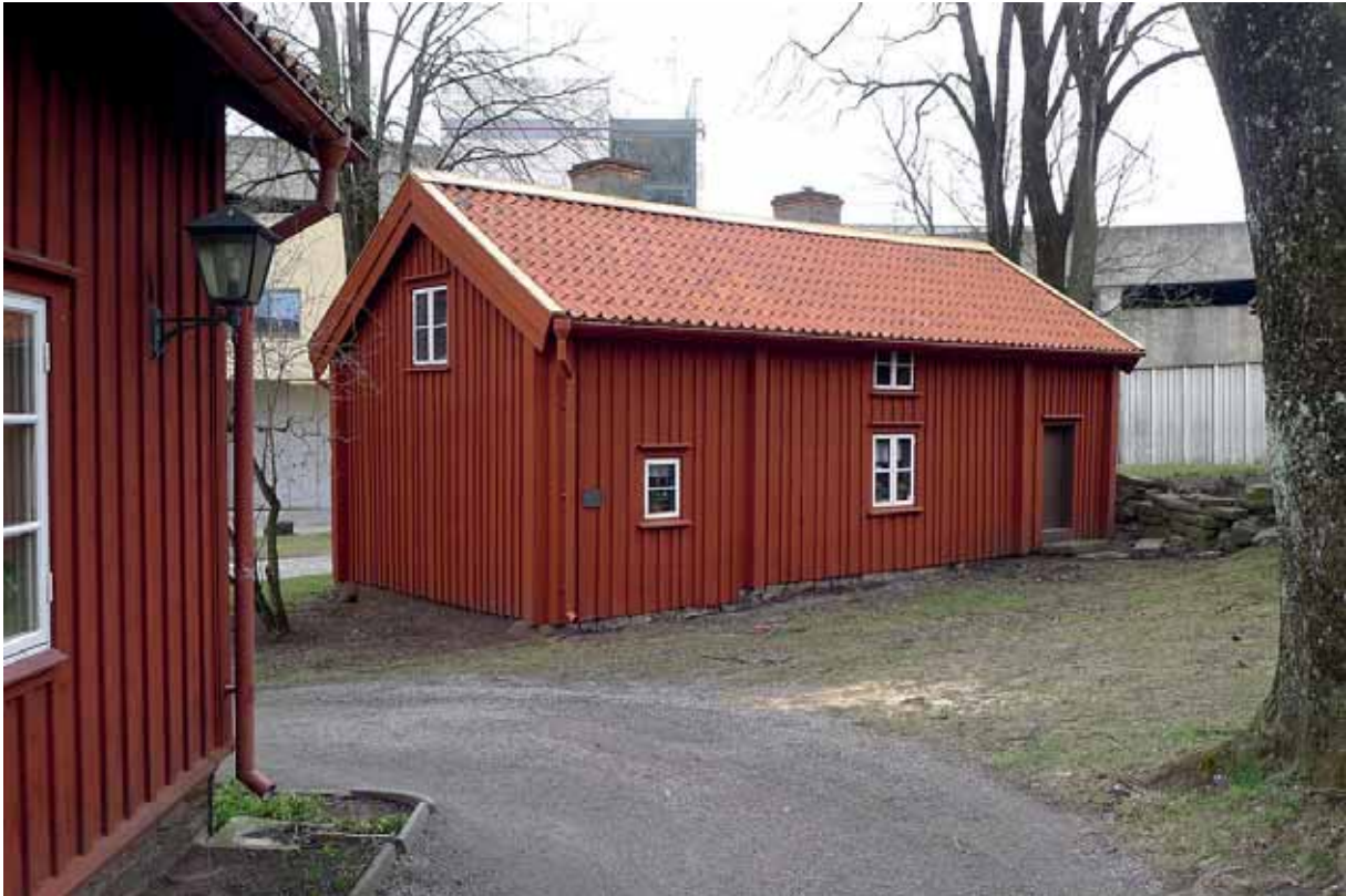
Arbetena på huset färdigställda, så när som på rödfärgning av vattbräder och nockbräder. 2 apr. 2016.
