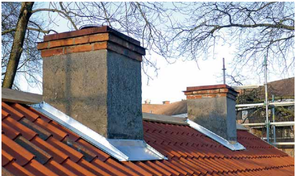
Nya plåtbeslag, bättre anpassade till byggnaden. Målas svarta sedan galvplåten oxiderat om några år. Samtidigt kan skorstenskrönen putsas. Febr 2016.
