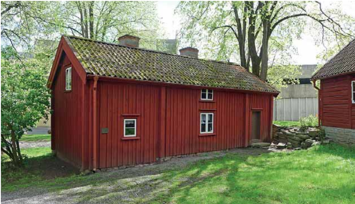
Helénstugan, fasad mot gården, före renovering. Maj 2015.
