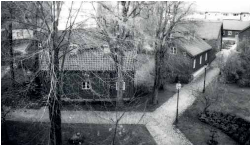
Helensgårdens byggnader från SO 1990. Närmast Helénstugan, t.h. det yngre bostadshuset och magasinet. Bakom Helénstugan skymtar ladugårdslängan.
