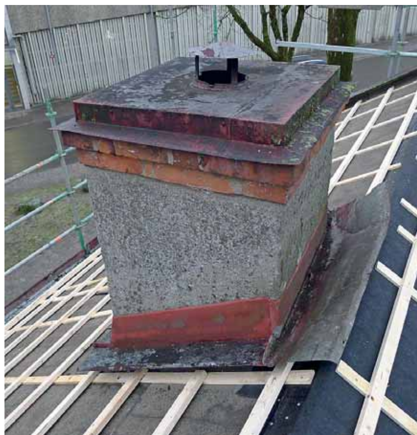
Skorstenarna, särskilt beslagen, behövde översyn och ev. byte. Maj 2015.
