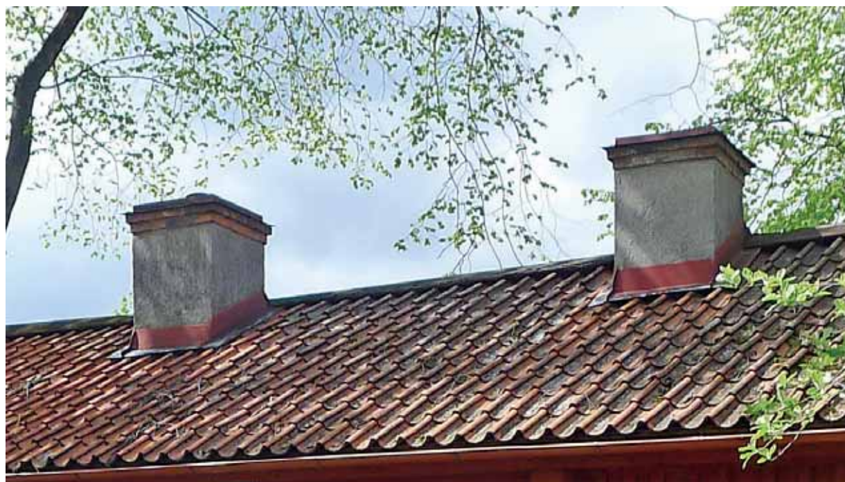
Skorstenarna, särskilt beslagen, behövde översyn och ev. byte. Maj 2015.
