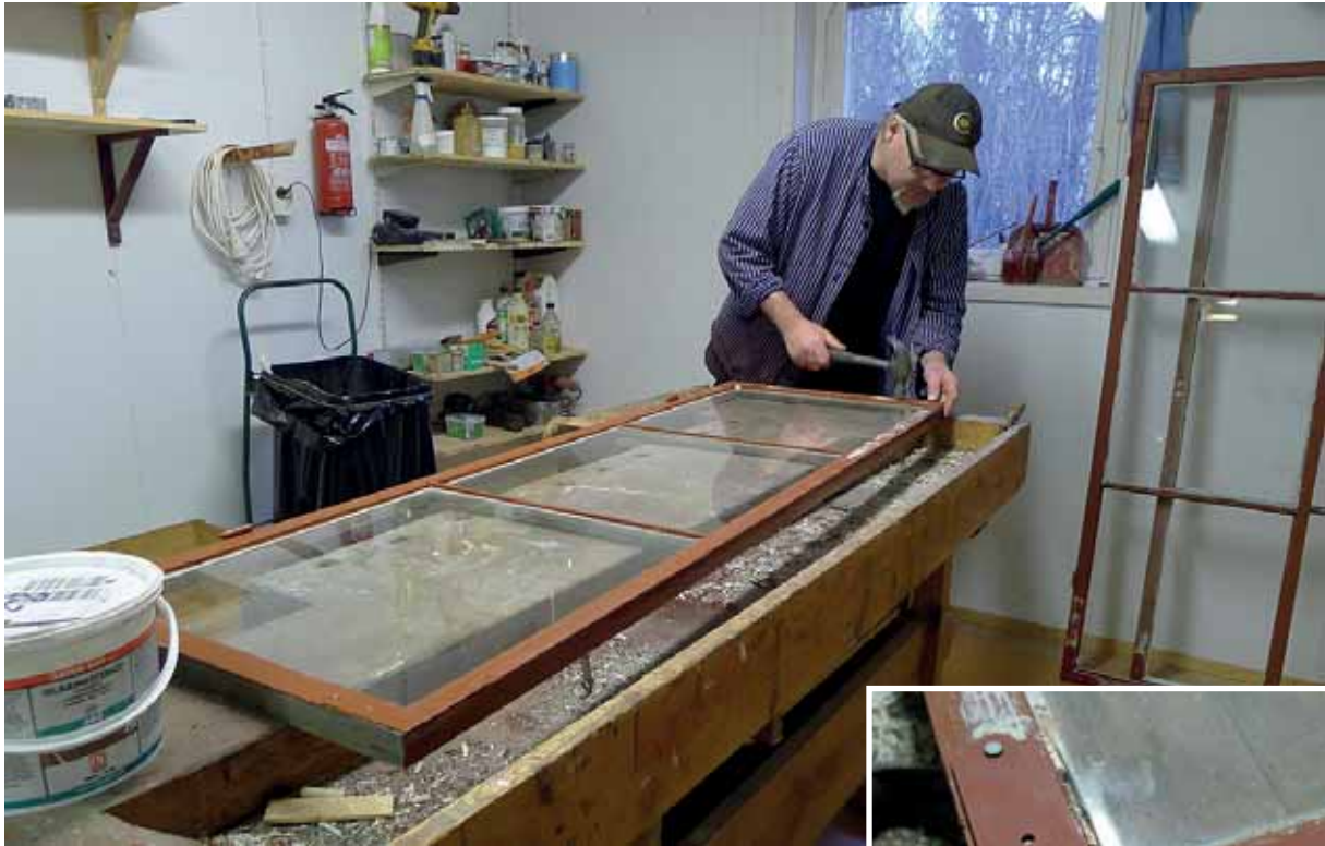
Ovan: Per Wahlström monterar ett hörnbeslag på en grundmålad båge. Höger: Särskilda spikar användes. Nov. 2015.
