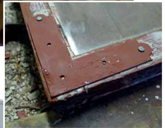
Ovan: Per Wahlström monterar ett hörnbeslag på en grundmålad båge. Höger: Särskilda spikar användes. Nov. 2015.
