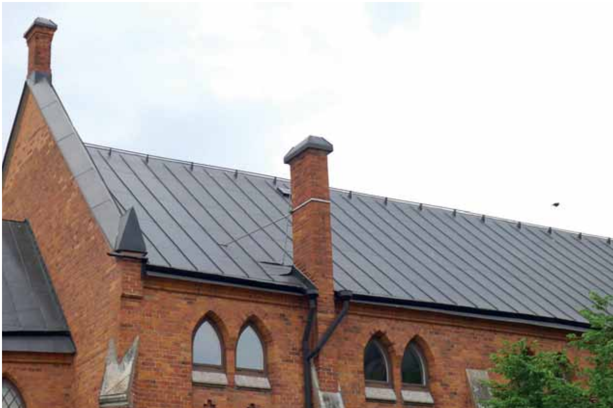
Taket målades svart sommaren 2015. Här östra takfallet 24 maj 2016.
