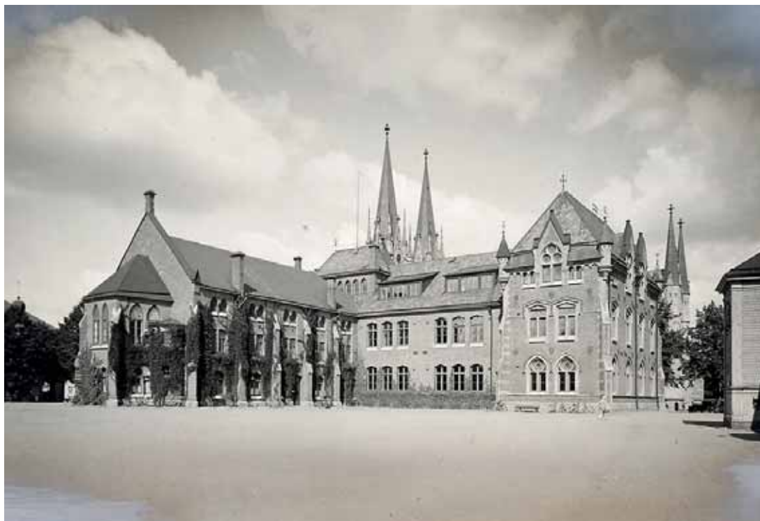
Skara Läroverk sett från sydost 1934. Precis som på 1870-talsbilden på föreg. sida är aulan täckt med plåt och huvudlängan med skiffer. Båda bilderna VGM bildarkiv.
