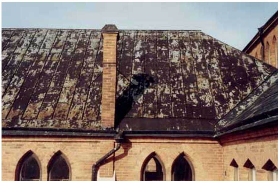
Östra takfallet efter rentvättning. Aug. 2005. 05/57.
