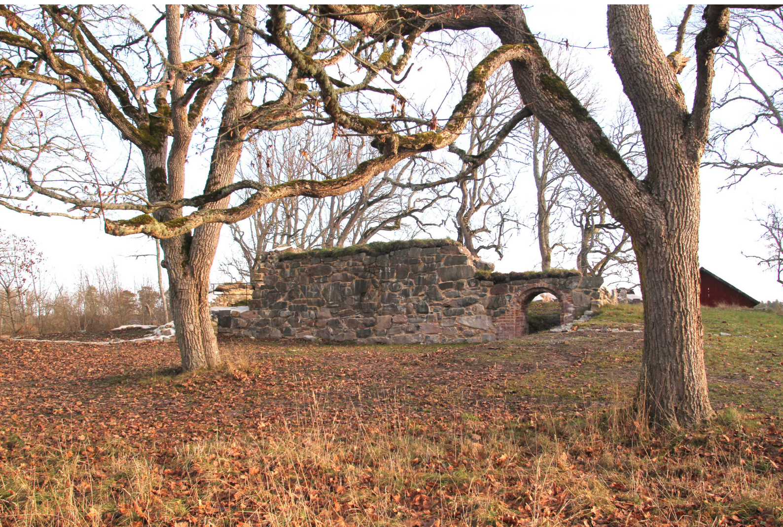
Den tvååriga konserveringsinsatsen på Lindholmens slottsruin avslutades under året (finansierat med bidrag från Lawskis fond), krönt av ny, mer informativ skyltning som besöksmålsåtgärd. Foto: Robin Gullbrandsson.
